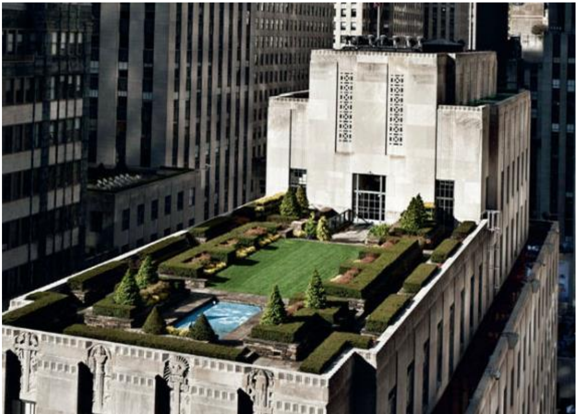
Figura 1 - Exemplo de um telhado verde no edifício Rockefeller Center, em Nova Iorque.
