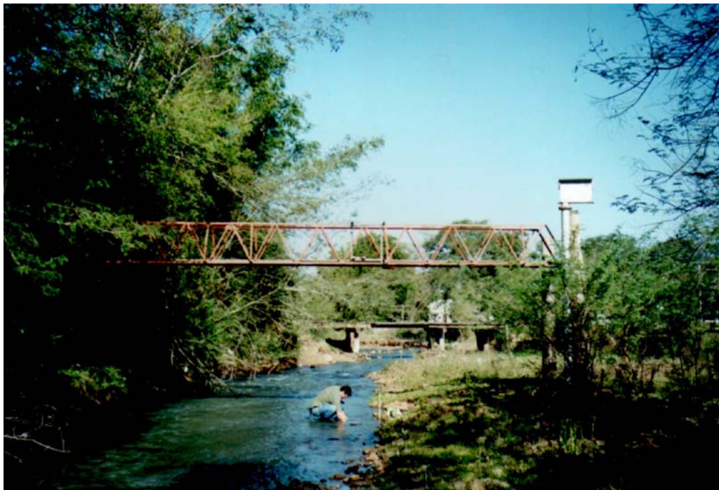
Figura 12 – Estação fluviométrica MD3
