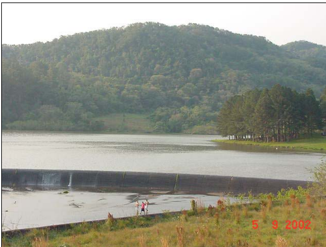
Figura 9 - Vertedor da barragem
