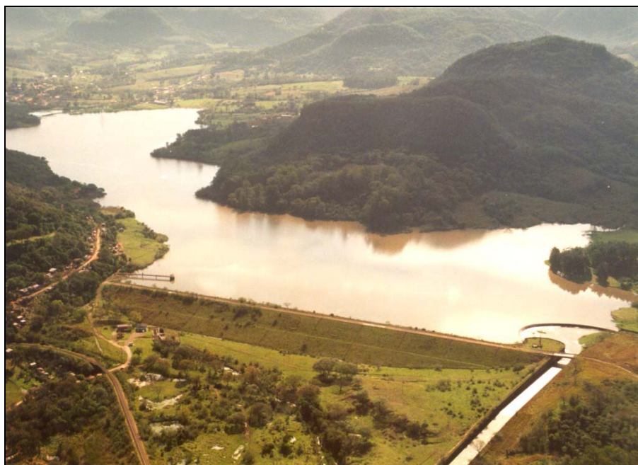
Figura 8 - Barragem do reservatório do Vacacaí-Mirim
