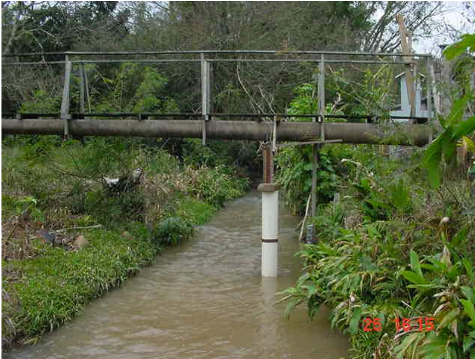
Figura 13 – Estação fluviométrica MD2
