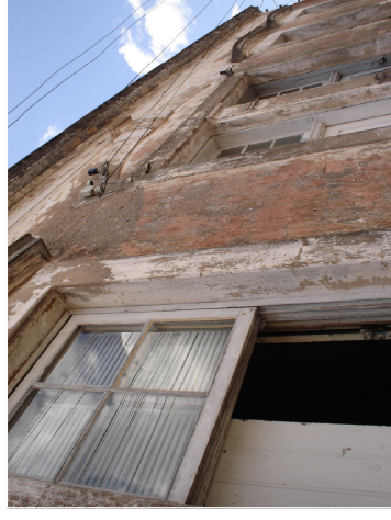
Vista da elevação principal Sul, edificações 5 e 6 (ACERVO DO AUTOR, 2007).
