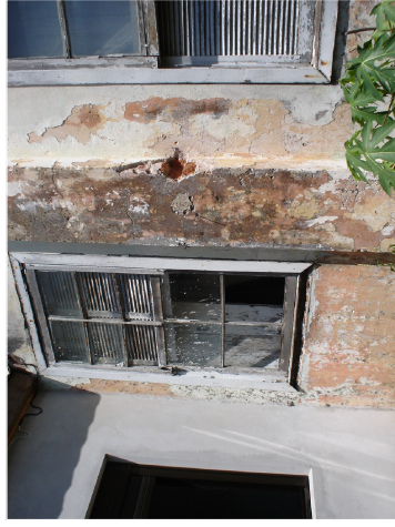
Vista da elevação Oeste, edificação 05 (ACERVO DO AUTOR, 2007).
