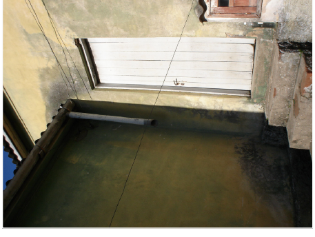
Vista da elevação Leste, edificação 03 (ACERVO DO AUTOR, 2007).
