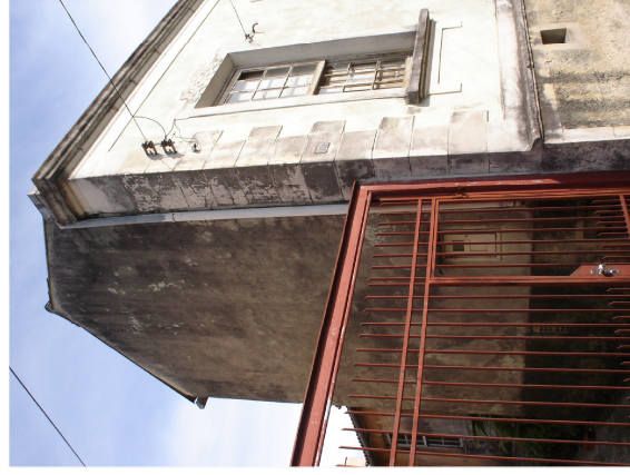
Vista detalhe elevação Leste (ACERVO DO AUTOR, 2007).
