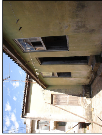
Vista das elevações Norte e Leste, edificação 04 (ACERVO DO AUTOR, 2007).
