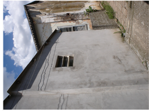
Vista da elevação Oeste, edificação 05 (ACERVO DO AUTOR, 2007).
