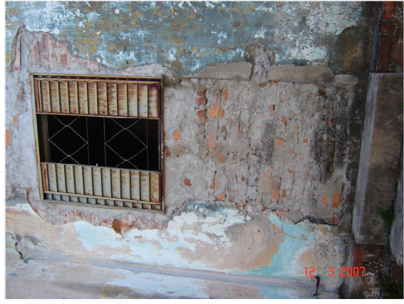
Vista em detalhe da elevação leste interna (ACERVO DO AUTOR, 2007).
