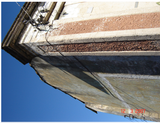
Vista em detalhe da elevação Norte (ACERVO DO AUTOR, 2007).
