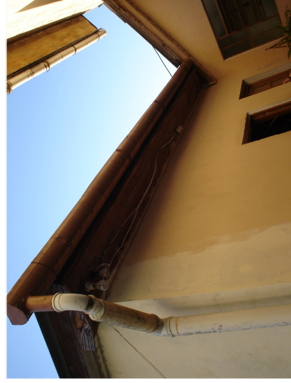
Vista em detalhe da elevação Leste interna (ACERVO DO AUTOR, 2007).
