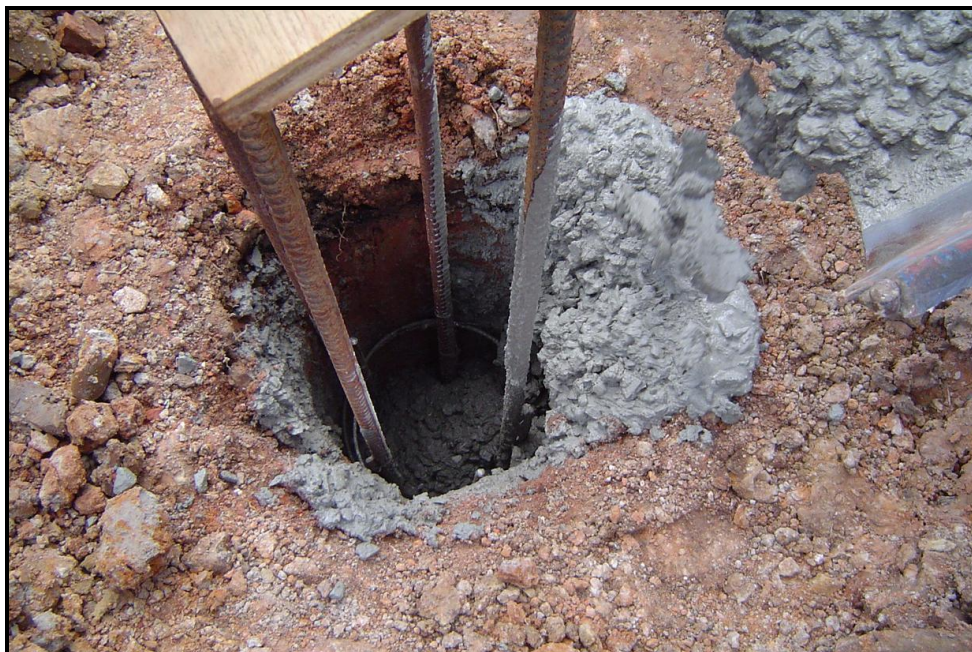
Figura 3.5 – Detalhe da concretagem das estacas de reação.
