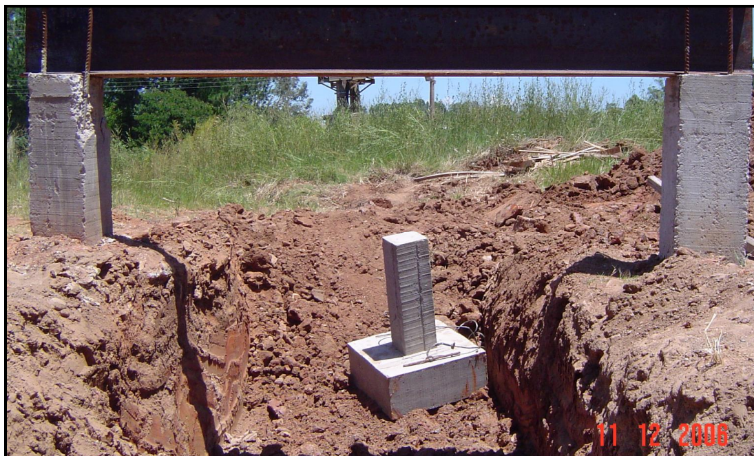
Figura 3.8 – Vista da vala aberta para o ensaio S-3 após a escavação mecânica.
