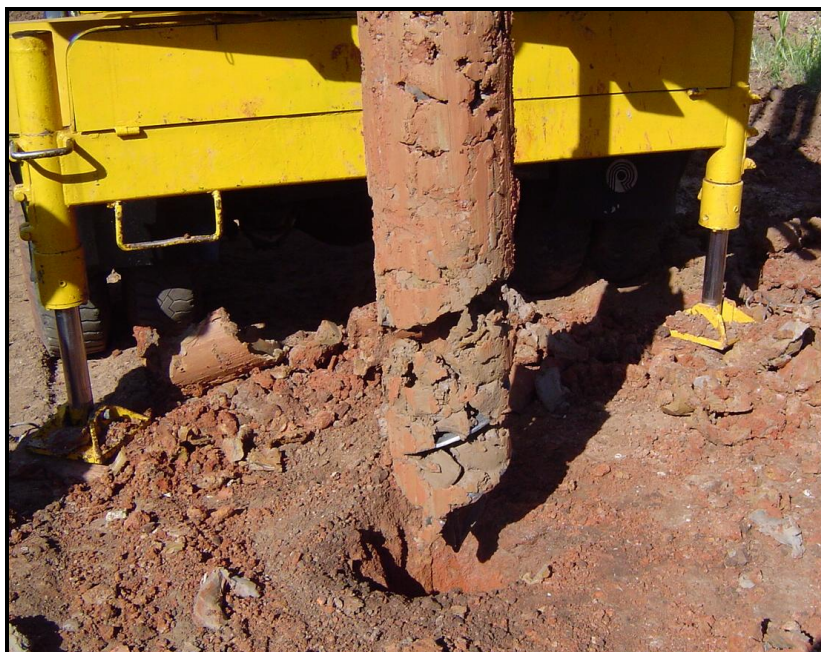
Figura 3.4 – Detalhe da escavação das estacas de reação.
