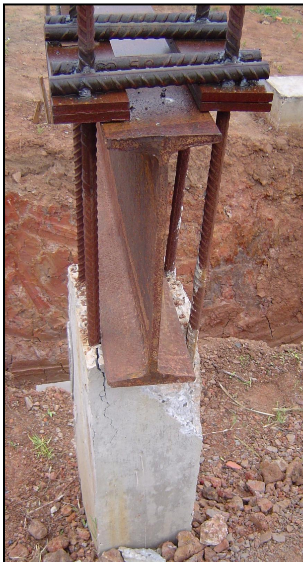
Figura 3.9 – Detalhe da viga de reação e sistema de fixação utilizado para o ensaio S-1.
