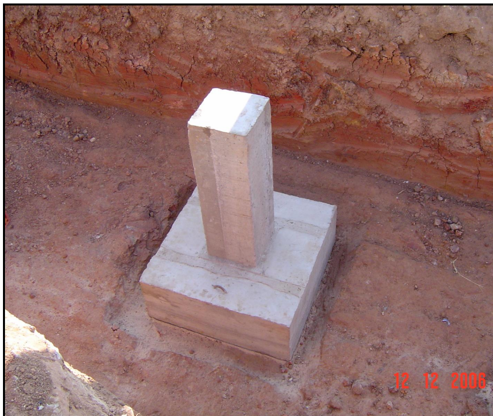
Figura 3.10 – Vista da vala aberta para o ensaio S-3 após a escavação manual.
