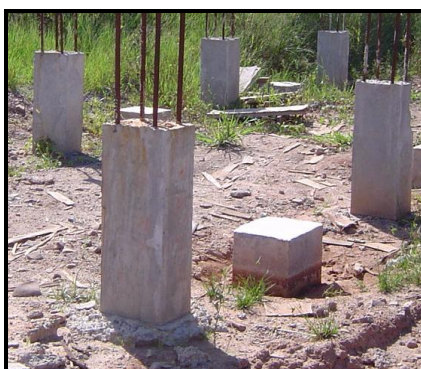
Figura 3.6 – Vista dos pilaretes sobre as estacas de reação.
