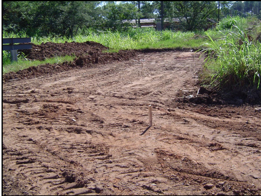
Figura 3.2 – Vista do local de estudo pós-operações de decapagem.
