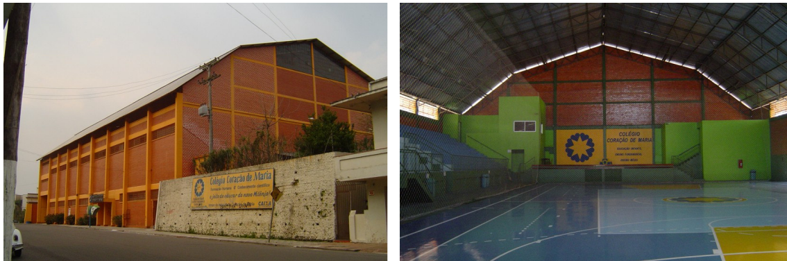
Figura 4.5 – Vistas externa e interna do Ginásio do Colégio Coração de Maria
