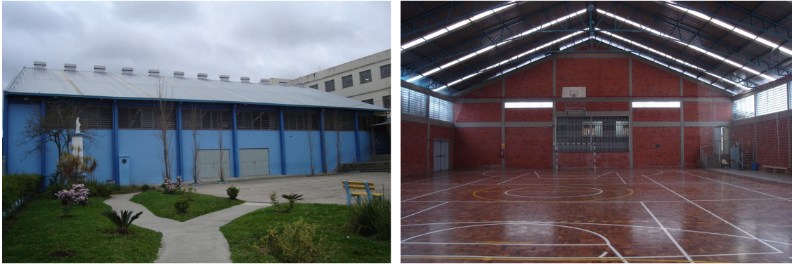
Figura 4.9 – Vistas externa e interna do Ginásio do Colégio Santa Catarina
