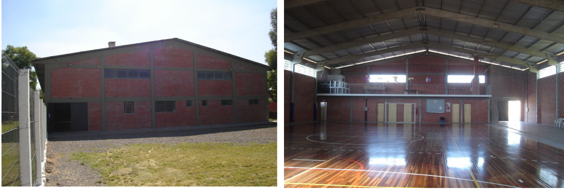
Figura 4.7 – Vistas externa e interna do Ginásio da Escola Paulo de Tarso
