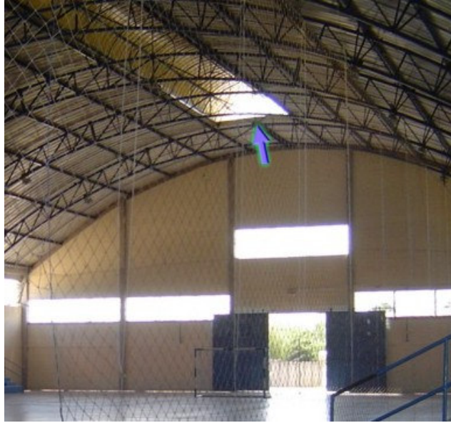
Figura 4.14 – Abertura de exaustão na cobertura do Ginásio SEST/SENAT
