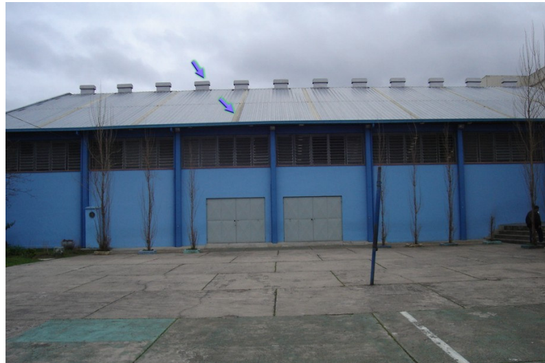
Figura 4.11 – Vista externa do Ginásio do Colégio Santa Catarina com destaque para mecanismos de exaustão e telhas translúcidas da cobertura
