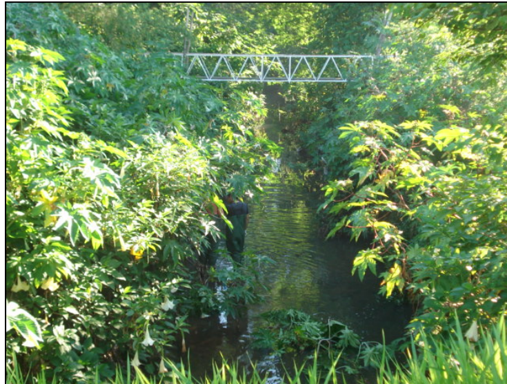
Figura 3.5 – Seção 3 de Monitoramento.
