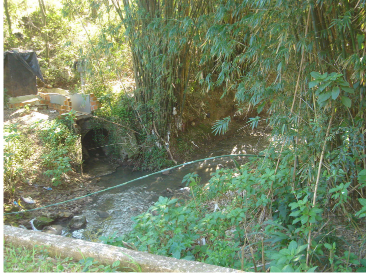
Figura 3.4 – Seção 2 de Monitoramento
