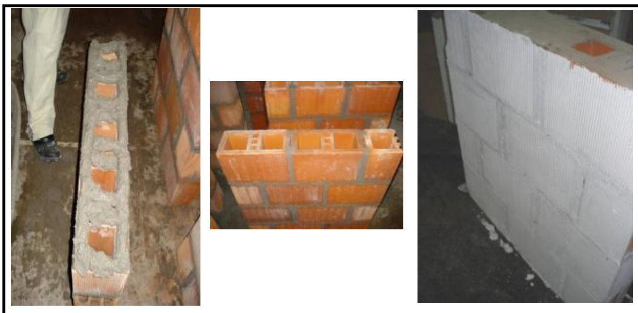
Figura 27 – Moldagem das pequenas paredes
