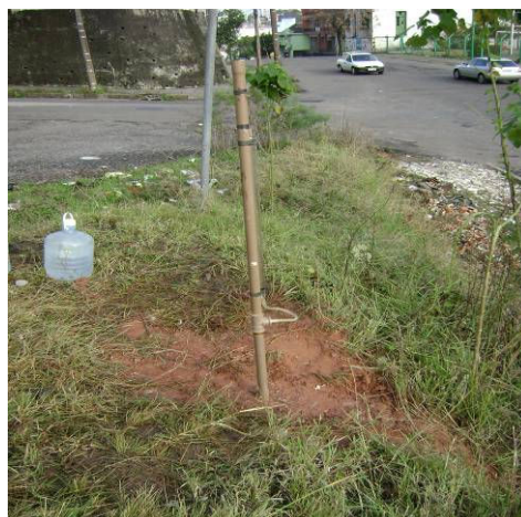
Figura 3.2 – Piezômetro instalado no campo.
