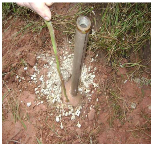
Figura 3.1 – Montagem do piezômetro.
