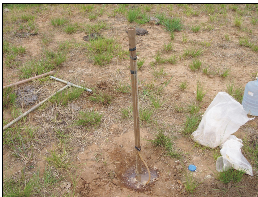
Figura 3.6 – Piezômetro instalado no campo. Fonte: Trabalho de campo (2008).
