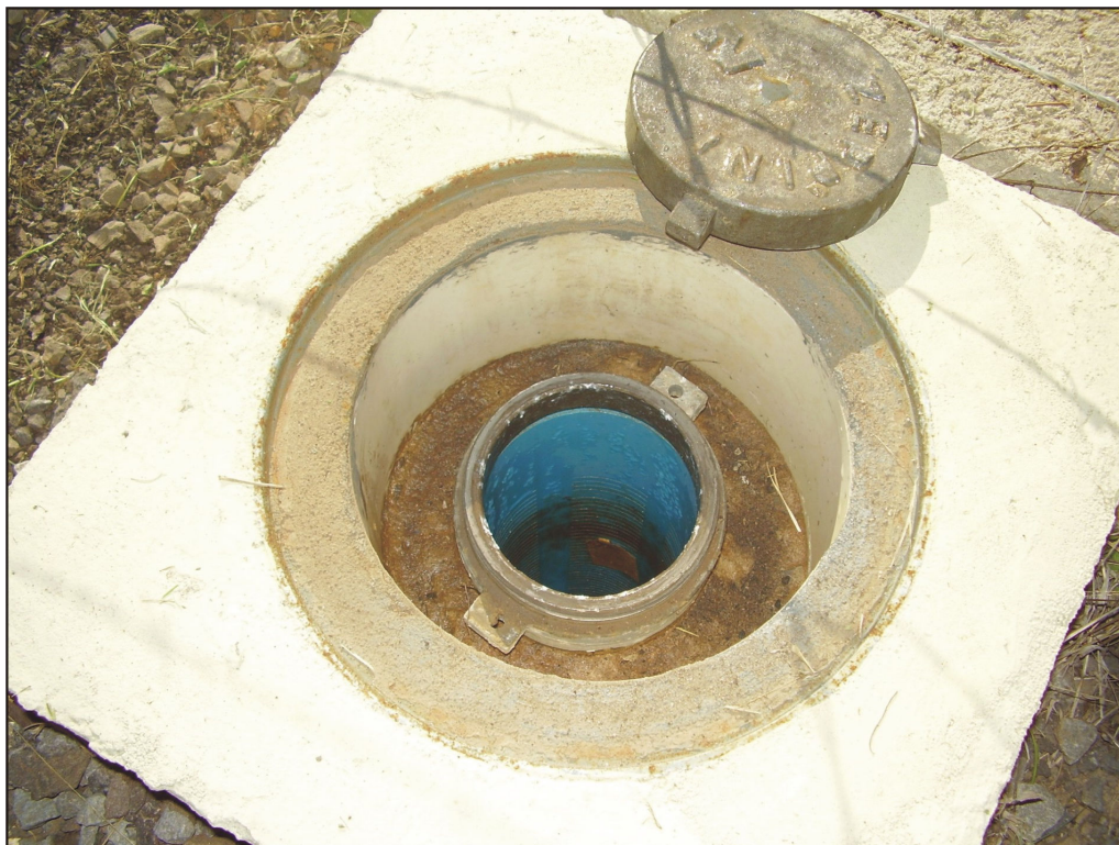
Figura 3.1 – Aspecto construtivo do poço de monitoramento P1. Fonte: Trabalho de campo (2008).
