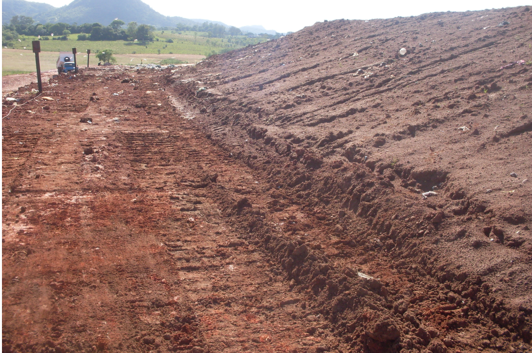
Figura 5.4 – Recobrimento de resíduos compactados e queimadores de gás
