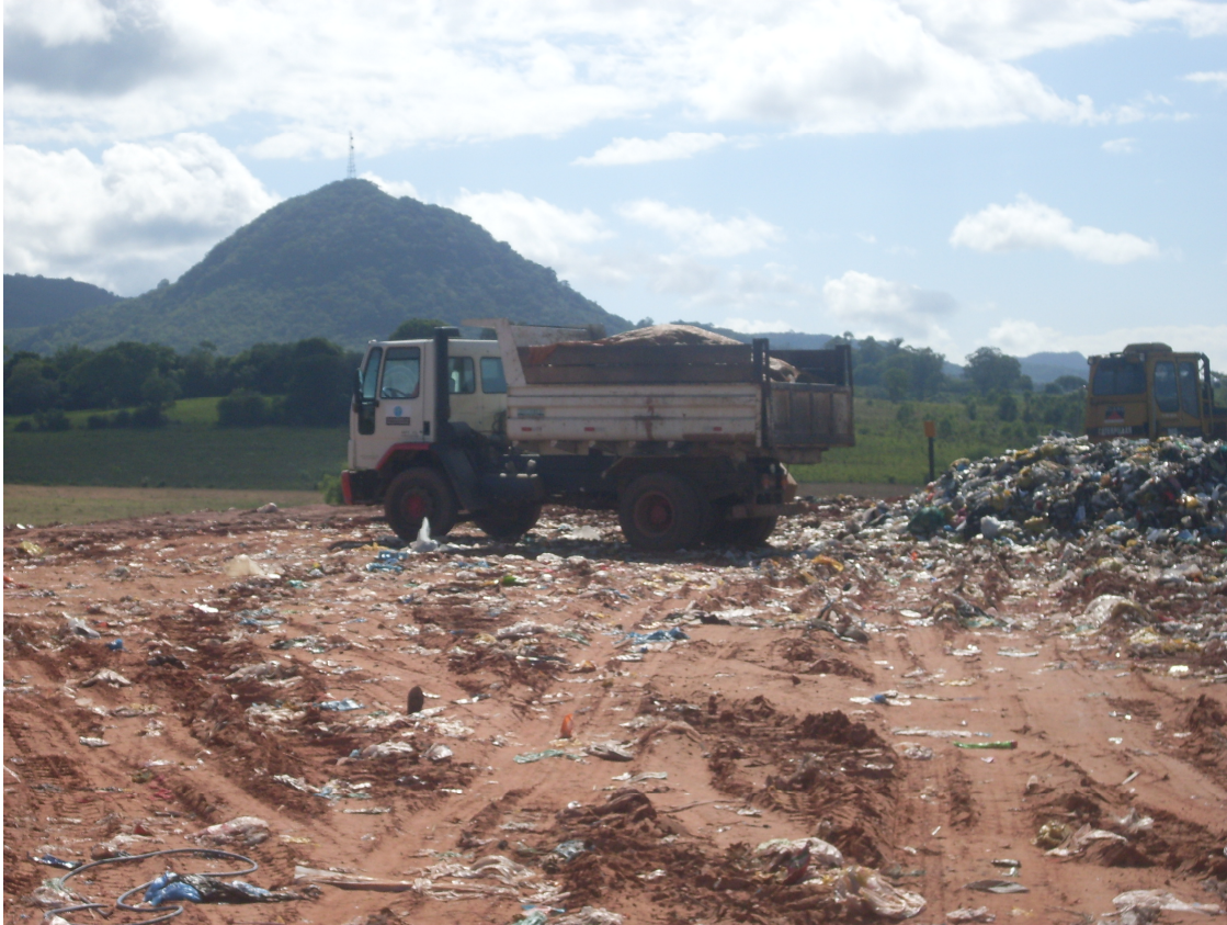
Figura 5.25 – Caçambas em serviço de recobrimento
