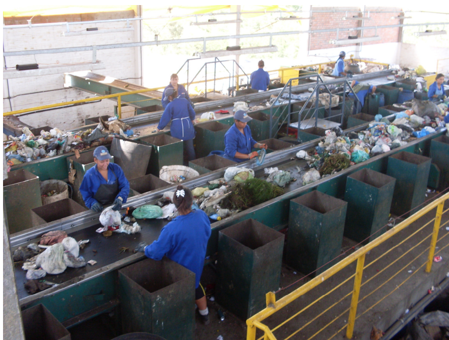
Figura 4.6 – Unidade de Triagem – Esteiras para transporte de resíduos
