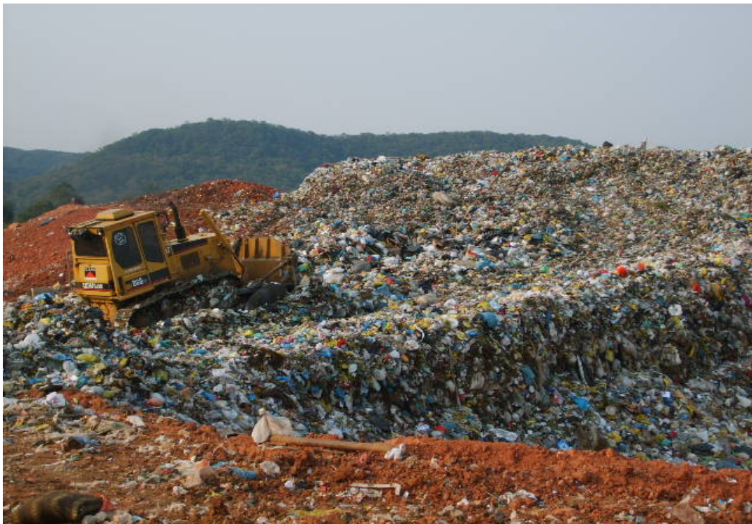
Figura 5.3 – Compactação de resíduos em rampa
