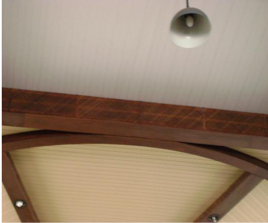
Figura 13: forro de PVC intercalado com ripas de madeira lisa e treliçada
