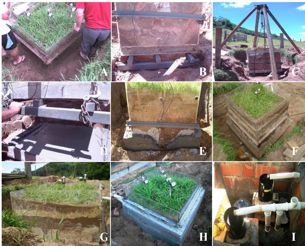
Figura 15 – Etapas do concerto do lisímetro instalado na sub-bacia Rancho do Amaral
