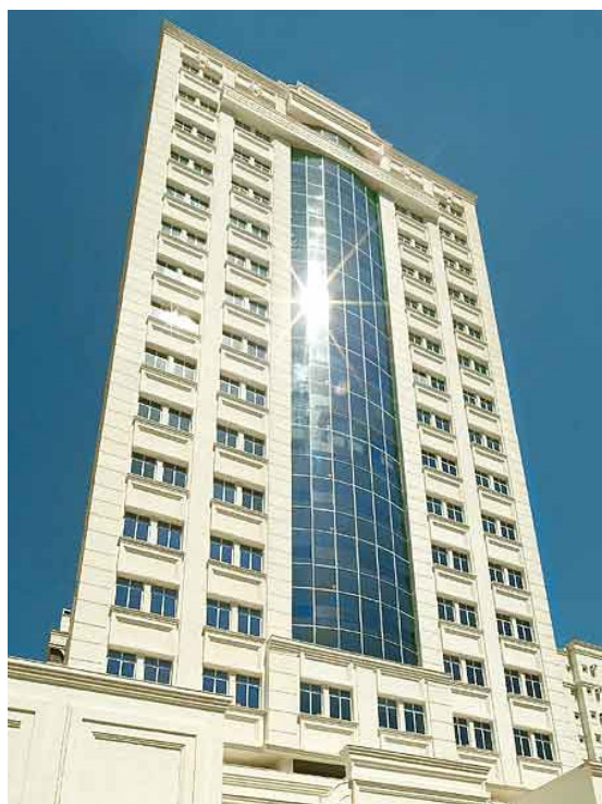
Figura 72 – Edifício Centro Profissional Getúlio Vargas
