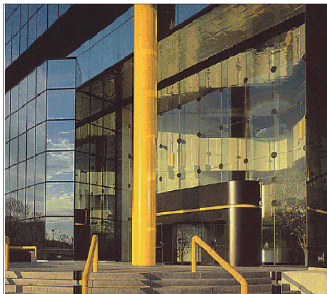
Figura 22 – Fachada pele de vidro
