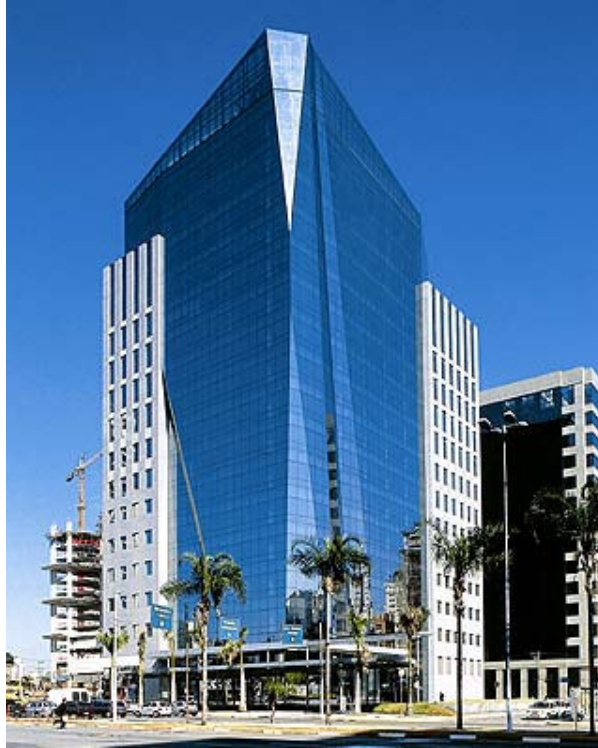
Figura 25 – Edifício Birmann 31 – São Paulo, SP
