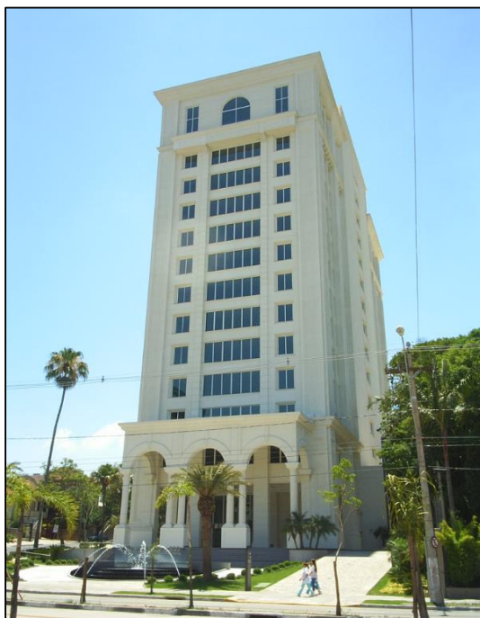
Figura 43 – Edifício Carlos Gomes 222
