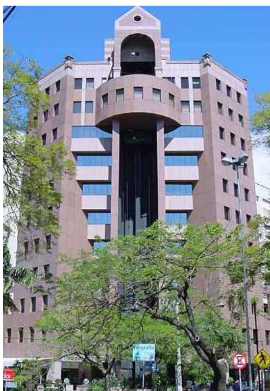
Figura 58 – Edifício Centro Profissional Uffizi
