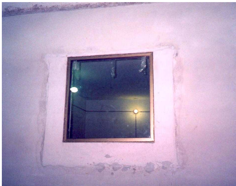
FIGURA 69 – Montagem dos caixilhos e vidros para os ensaios na câmara reverberante.
