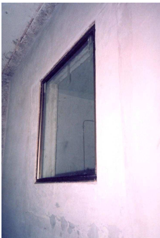
FIGURA 71 – Ensaio de vitragem dupla com o menor afastamento.
