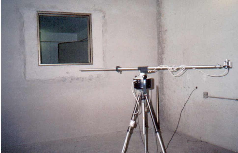
FIGURA 46: Parede de alvenaria e caixilho para colocação dos vidros testados.
