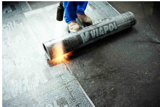
Figura 13 – Execução de manta asfáltica com maçarico. (VIAPOL, 2008).
