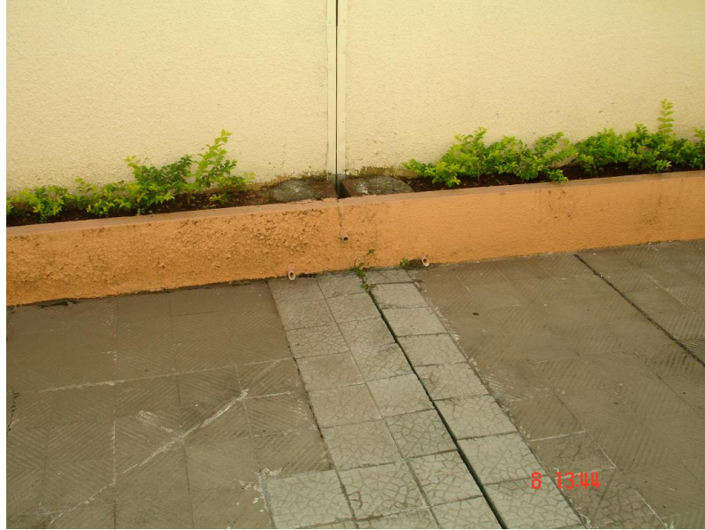
Figura 52 — Junta de dilatação (ACERVO DO AUTOR, 2007).
