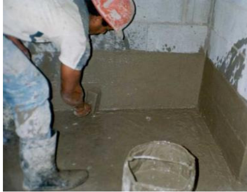
Figura 11 – Execução de membrana acrílica (SABBATINI, 2006, p.3).
