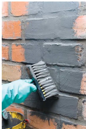
Figura 4 – Aplicação de cristalizante na forma de pintura. (NAKAMURA, 2006, p. 28).
