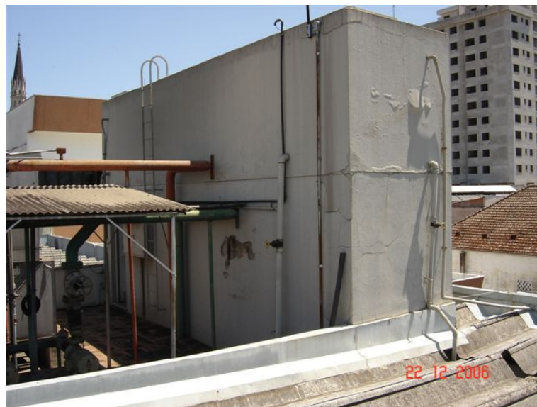
Figura 47 – Vista do reservatório do lado externo. (ACERVO DO AUTOR, 2007).
