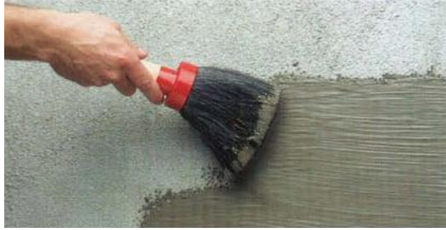
Figura 7 – Aplicação de argamassa polimérica na forma de pintura. (SAYEGH, 2001, p. 44)
