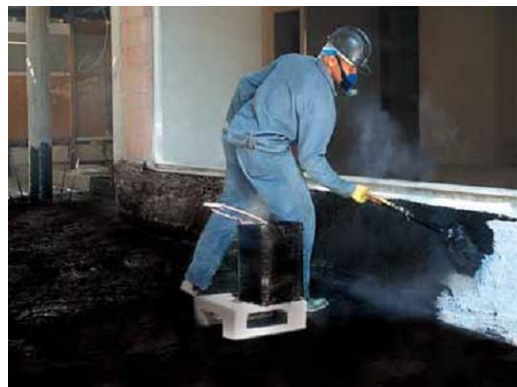
Figura 10 – Execução de membrana de asfalto a quente. (LWART, 2009, p. 32).
