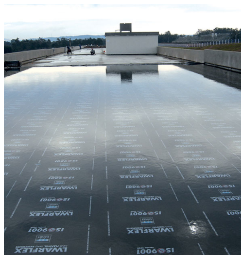
Figura 14 – Teste de estanqueidade. (ACERVO DO AUTOR, 2007).
