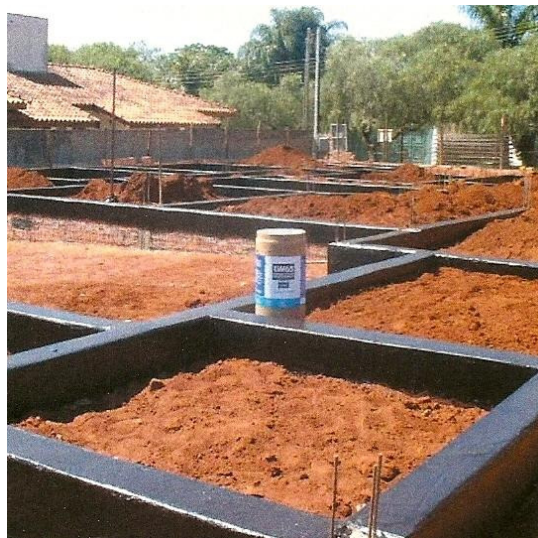
Figura 40 – Impermeabilização dos baldrames com membrana asfáltica. (MARQUES, 2005, p. 49).
