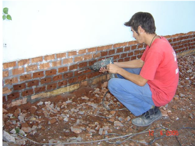
Figura 43 – Aplicação de cristalizante em alvenaria de tijolos maciços. (ACERVO DO AUTOR, 2007).
