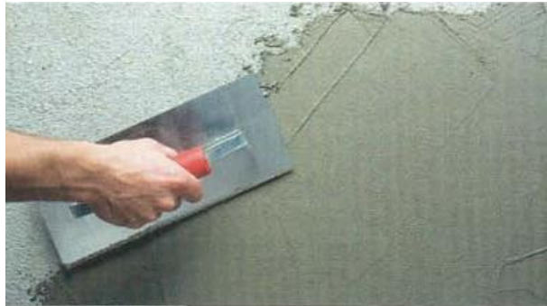
Figura 8 – Aplicação de argamassa polimérica na forma de revestimento. (SAYEGH, 2001, p. 44)
