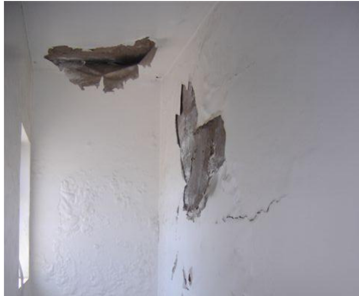
Figura 46 – Patologia em reservatório. (ACERVO DO AUTOR, 2007).
