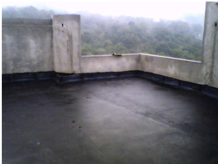
Figura 12 – Imprimação da superfície (ACERVO DO AUTOR, 2007).
