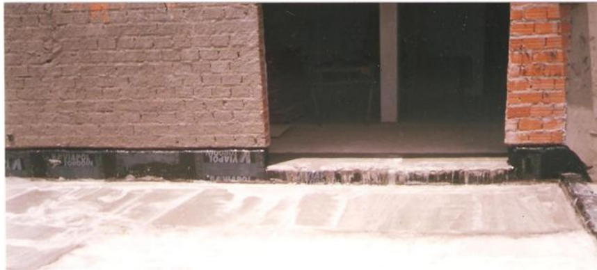
Figura 23 – Execução de manta asfáltica em rodapé. (ACERVO DO AUTOR, 2007).
