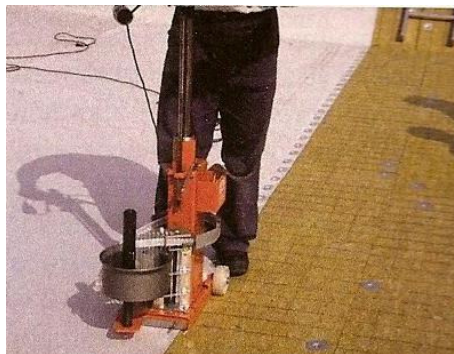
Figura 17 – Fixação automática com parafusos e arruelas especiais. (SILVA E OLIVEIRA, 2006, p. 77).
