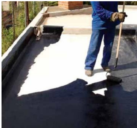
Figura 9 – Execução de membrana de asfalto a frio. (LWART, 2009, p. 6).
