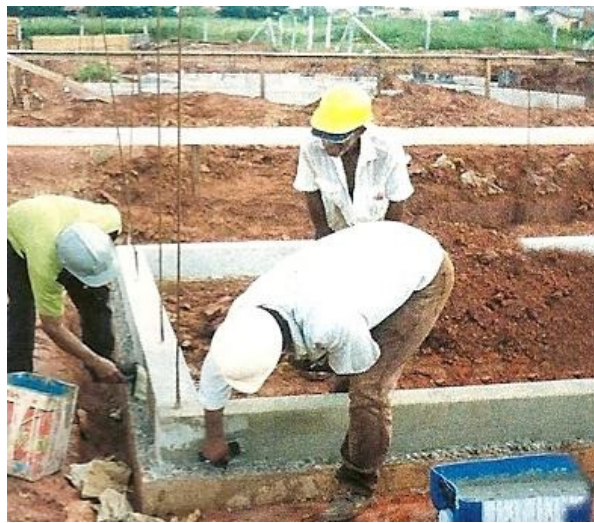
Figura 39 – Impermeabilização dos baldrames com argamassa polimérica. (MARQUES, 2005, p. 49).
