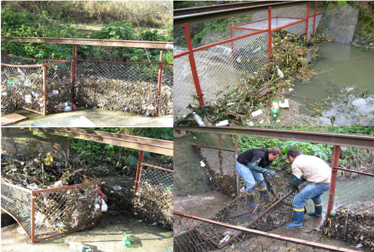
Figura 26 - Cesto removível à jusante (a), à montante (b) ao curso d'água, cestos sendo removidos (c) e (d).
