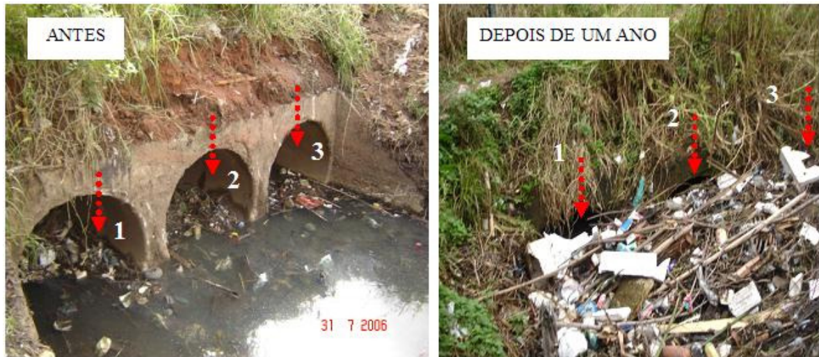
Figura 41 - Bueiro a jusante da estação de monitoramento, em situação antes e depois de um ano da limpeza.
