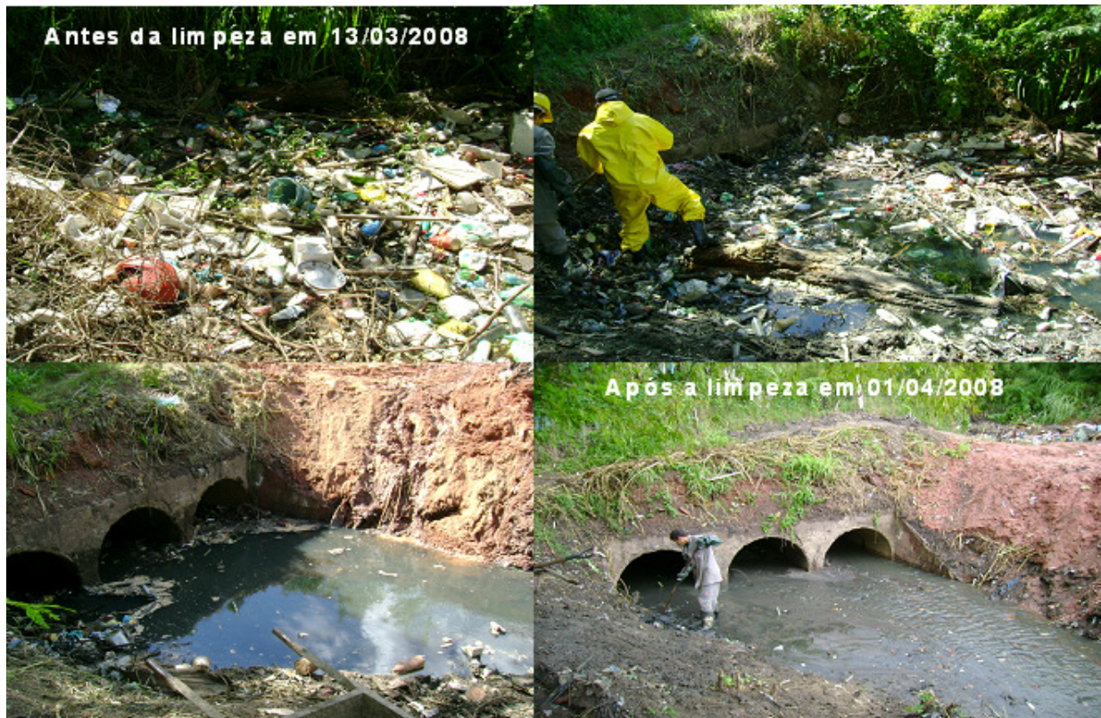
Figura 25 - Fotos retiradas do mesmo local em períodos diferentes: antes da limpeza (a), durante a limpeza manual (b), após a limpeza com retroescavadeira (c) e o serviço manual para finalização do trabalho da máquina retroescavadeira (d).
