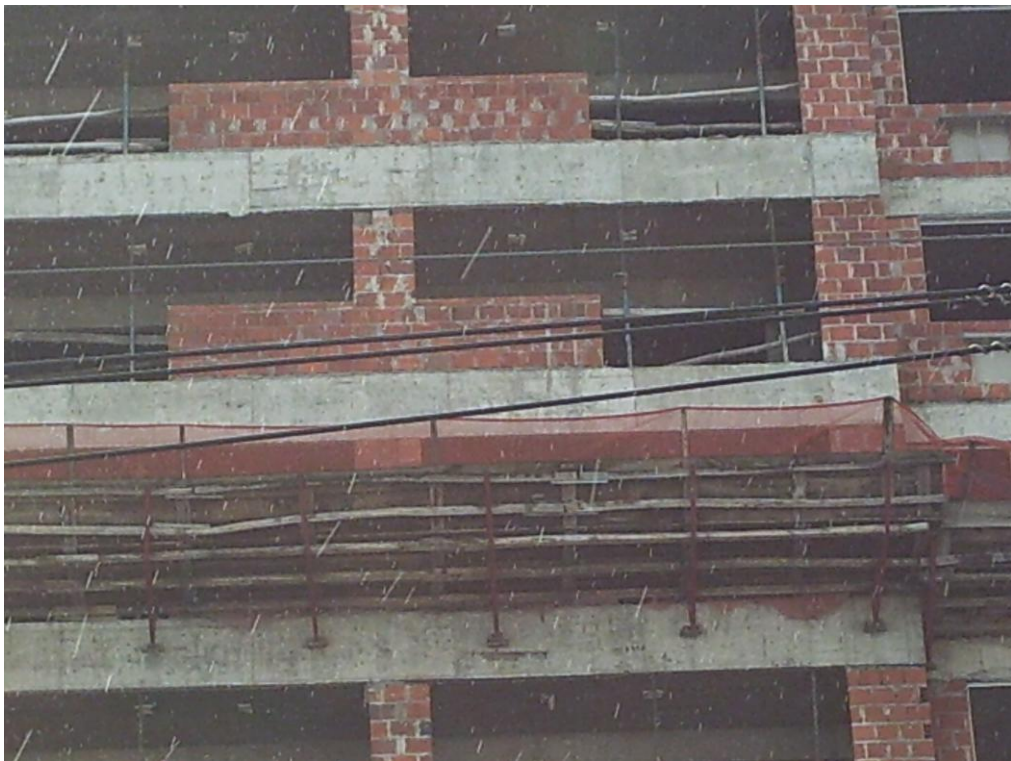
Figura 25 – Plataforma de proteção (bandejas) – vista 2
