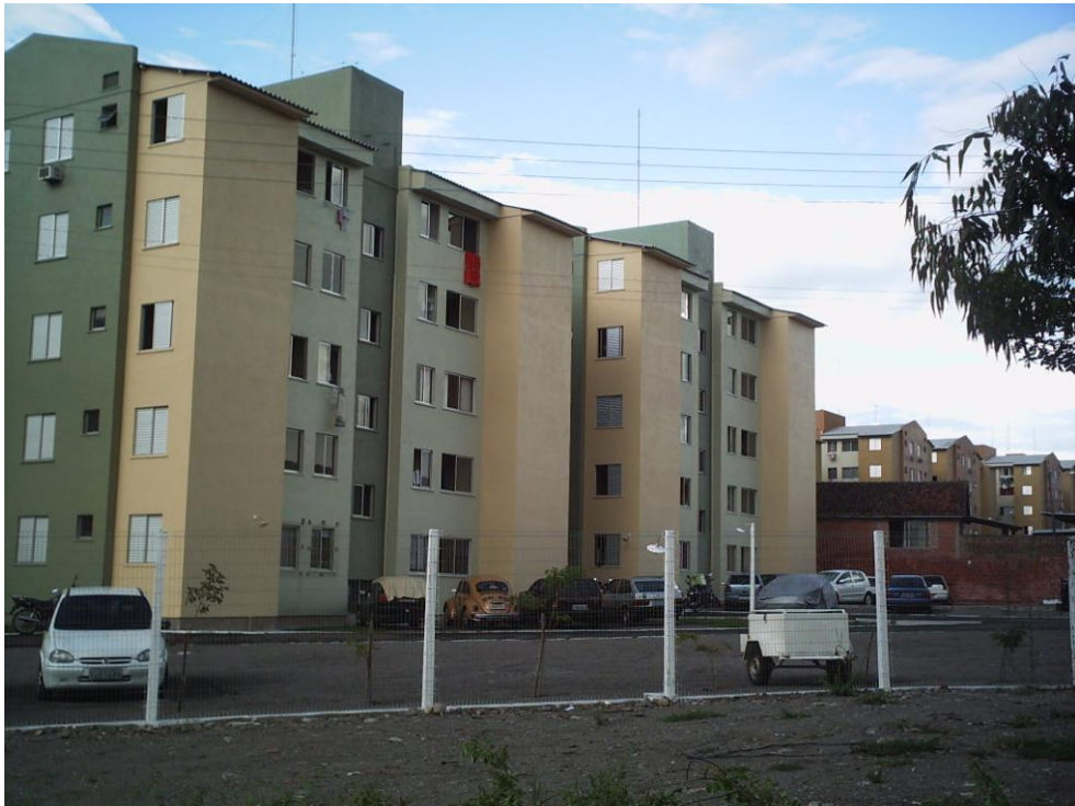
Figura 7 – Edificação em alvenaria estrutural acabada
