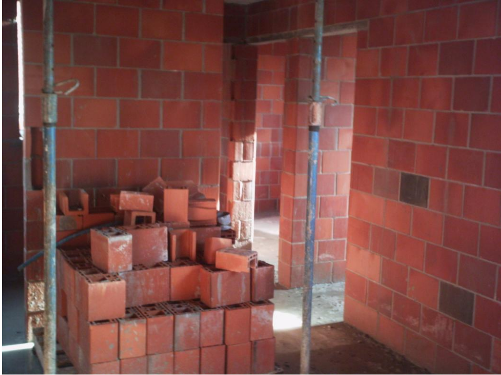
Figura 13 – Escoramento e alvenarias – vista 2
