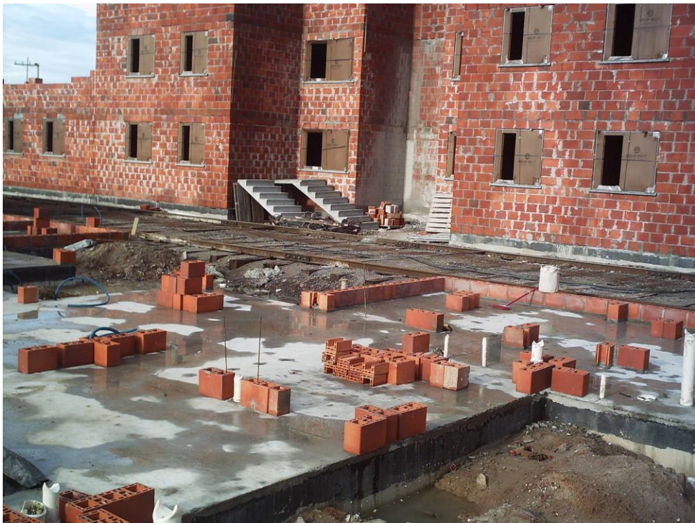
Figura 15 – Início da amarração dos blocos estruturais
