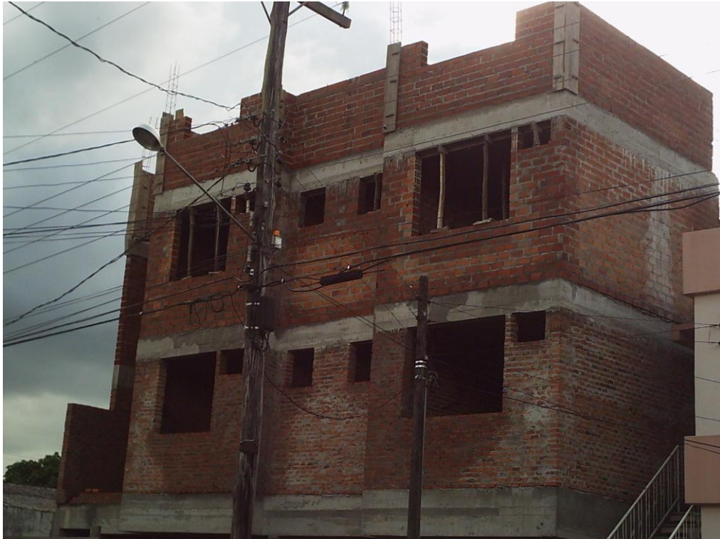
Figura 6 – Fachada convencional (detalhe)
