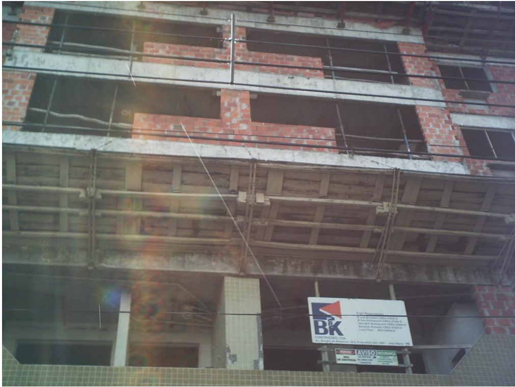
Figura 25 – Plataforma de proteção (bandejas) – vista 2
