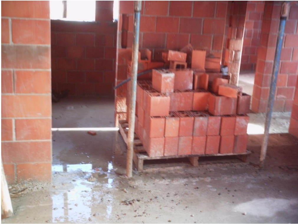
Figura 15 – Início da amarração dos blocos estruturais
