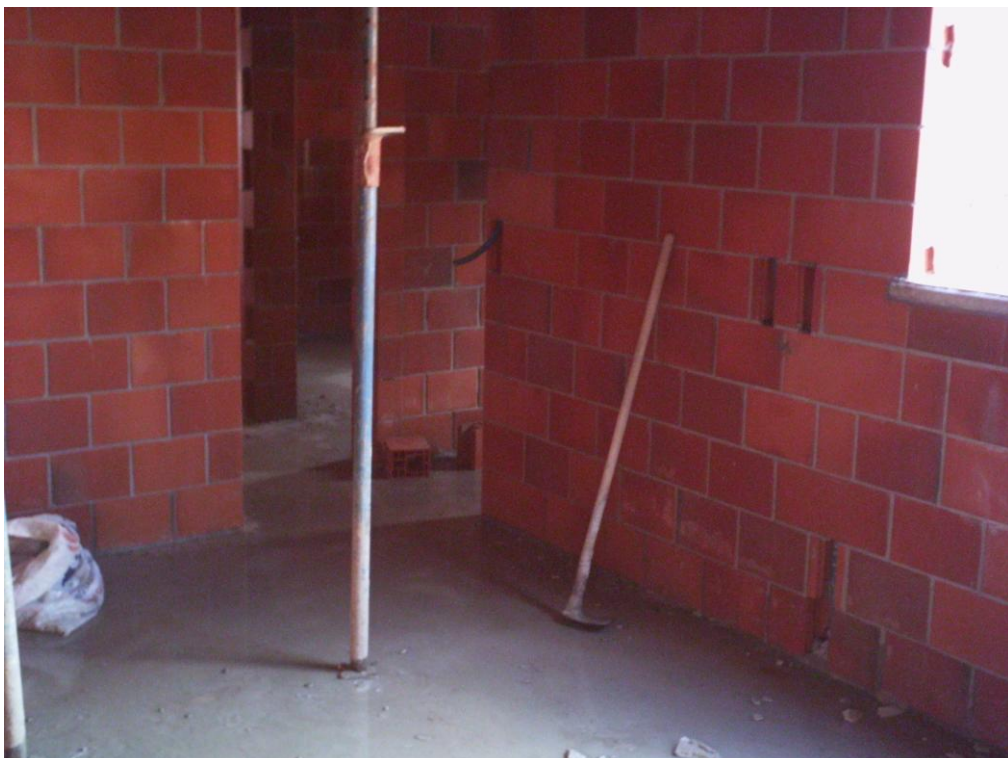
Figura 9 – Interior de uma construção em alvenaria estrutural – vista 2
