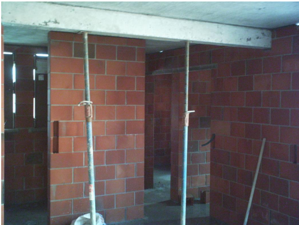
Figura 13 – Escoramento e alvenarias – vista 2
