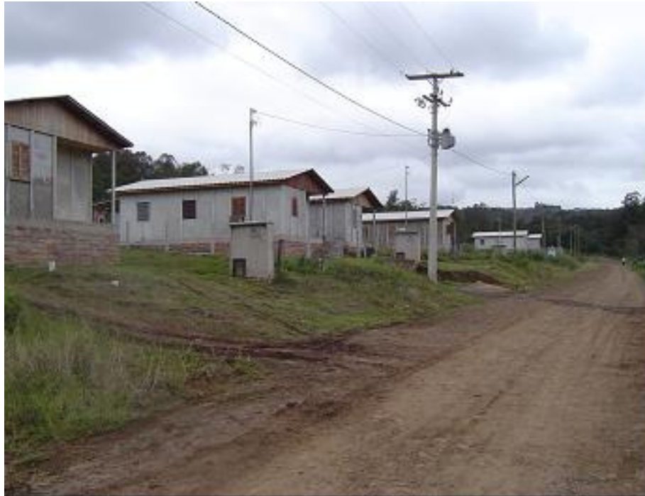
Figura 21 – Vista de um dos loteamentos sem pavimentação na rua.
