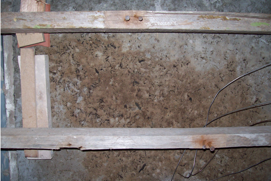
Figura 50 – Vista externa da placa de 3 cm do segundo ensaio (aquecimento até 682,3°C): apresenta manchas forte de marrom na área central da placa.
