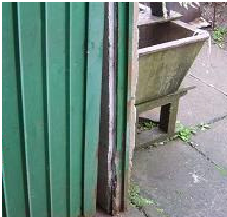
Figura 25 – Porta em ferro com ferrugem e solta na dobradiça.
