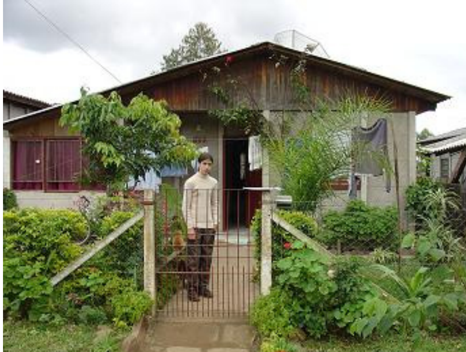
Figura 29 – Ampliação da casa, uso da vegetação no entorno.
