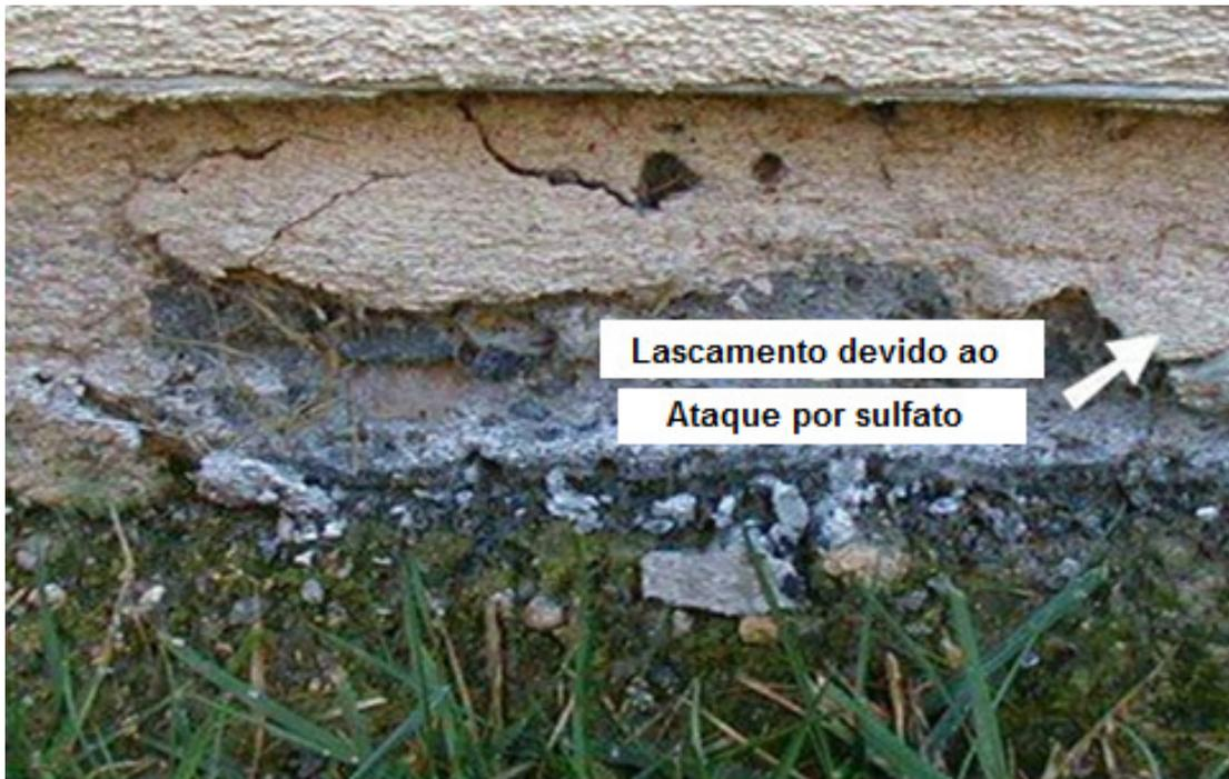
Figura 3 – Lascamento devido ao ataque por sulfato.
