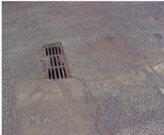
Figura 13 – Piso de concreto atacado pelo escoamento de soluções de ácidos e sulfatos através de águas pluviais.
