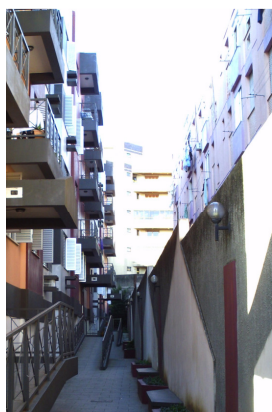
Figura 126 – Iluminação das áreas externas.
