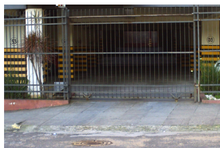
Figura 117 – Guias rebaixadas para carro.
