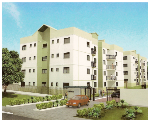
Vista da edificação
