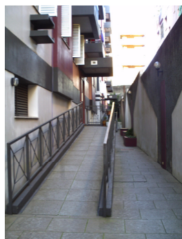
Figura 118 – Rampas de acesso aos blocos.
