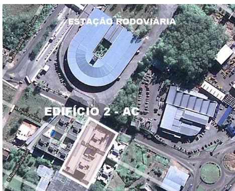
Figura 9 – Imagem aérea do Edifício 2. Fonte: Google.
