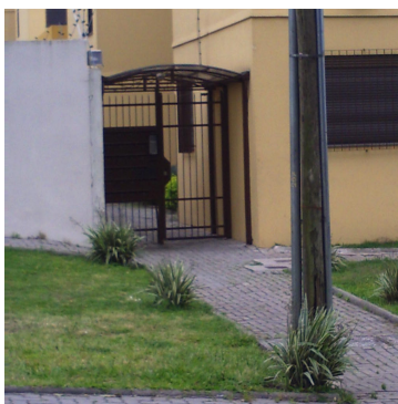
Figura 75 – Sistema de interfone existente.
