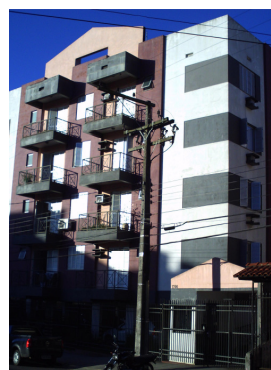
Figura 14 – Imagem frontal do Edifício 3. Fonte: Arquivo pessoal.
