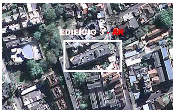
Figura 13 – Imagem aérea do Edifício 3. Fonte: Google.
