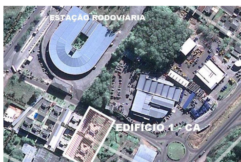
Figura 5 – Imagem aérea do Edifício 1. Fonte: Google.
