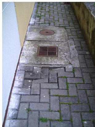
Figura 77 – Pavimentação com desnível inadequado. Figura 78 – Afundamento do piso.
