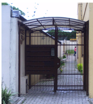
Figura 82 – Caixa de correio de acordo com as normas da EBCT.
