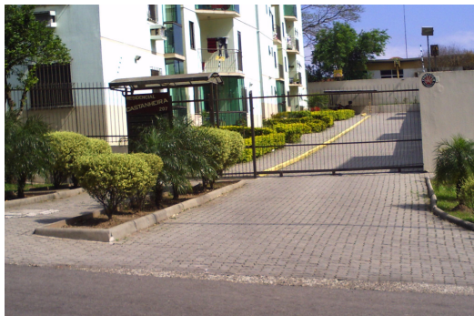
Figura 40 – Calçada apresentando acesso adequado para pedestres e automóveis do Edifício 1.
