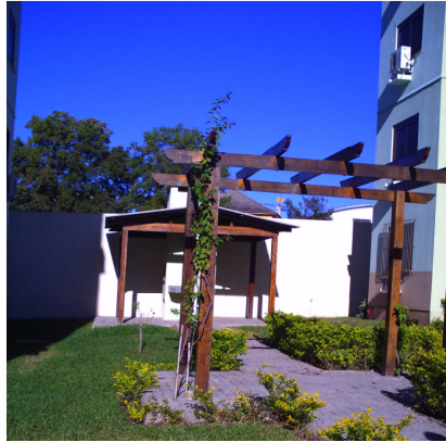
Figura 37 – Quiosque do Edifício 1 em bom estado.
