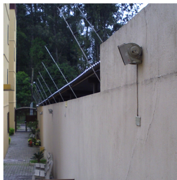
Figura 86 – Iluminação interna do condomínio.
