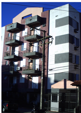
Vista da Edificação
