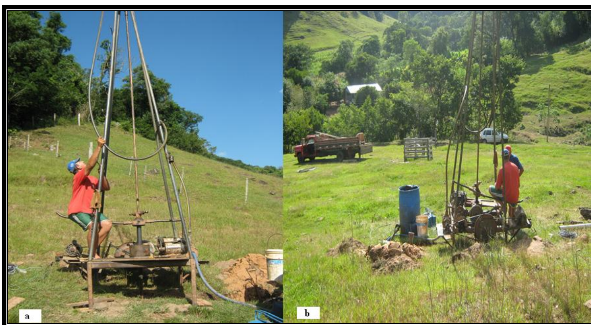
Figuras 13 a e b: Instalação da máq. perfuratriz e operação de perfuração, notar pluviógrafo ao fundo, em (b).
