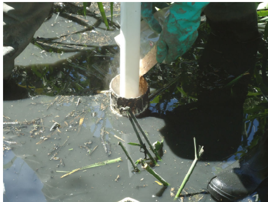
Figura 11 - Colocação do pré-filtro no poço raso.
