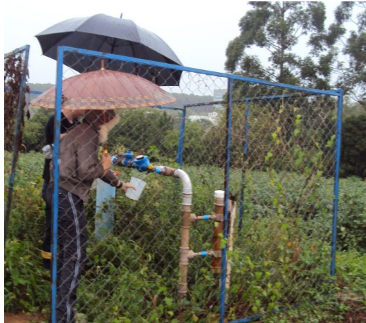
Figura 29 - Coleta de amostra de água subterrânea no poço de bombeamento PB-15.
