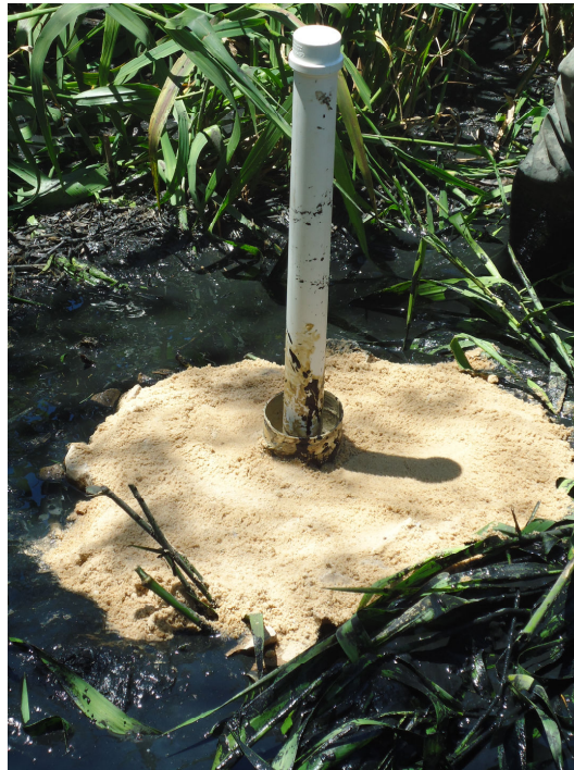
Figura 13 - Poço PMR-01 instalado.
