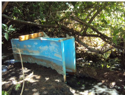
Figura 17 - Medição de vazão com calha Parshall no ponto FP-31A, vista lateral.
