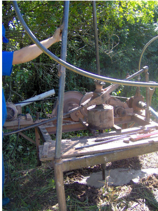
Figura 14 - Perfuração do poço PM-02 por meio de percussão com jato de água.
