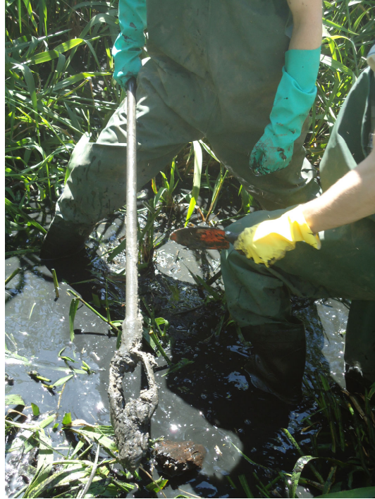
Figura 10 - Perfuração dos poços rasos por trado holandês 4" de diâmetro.
