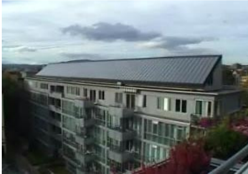
Figura 2.39 – Bloco de aquecimento, situado na cobertura do edifício.
