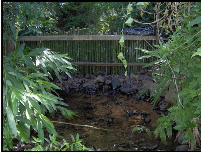
Figura 17 - Barramento construído no leito do rio, na proximidade da estação fluviométrica Menino Deus II.
