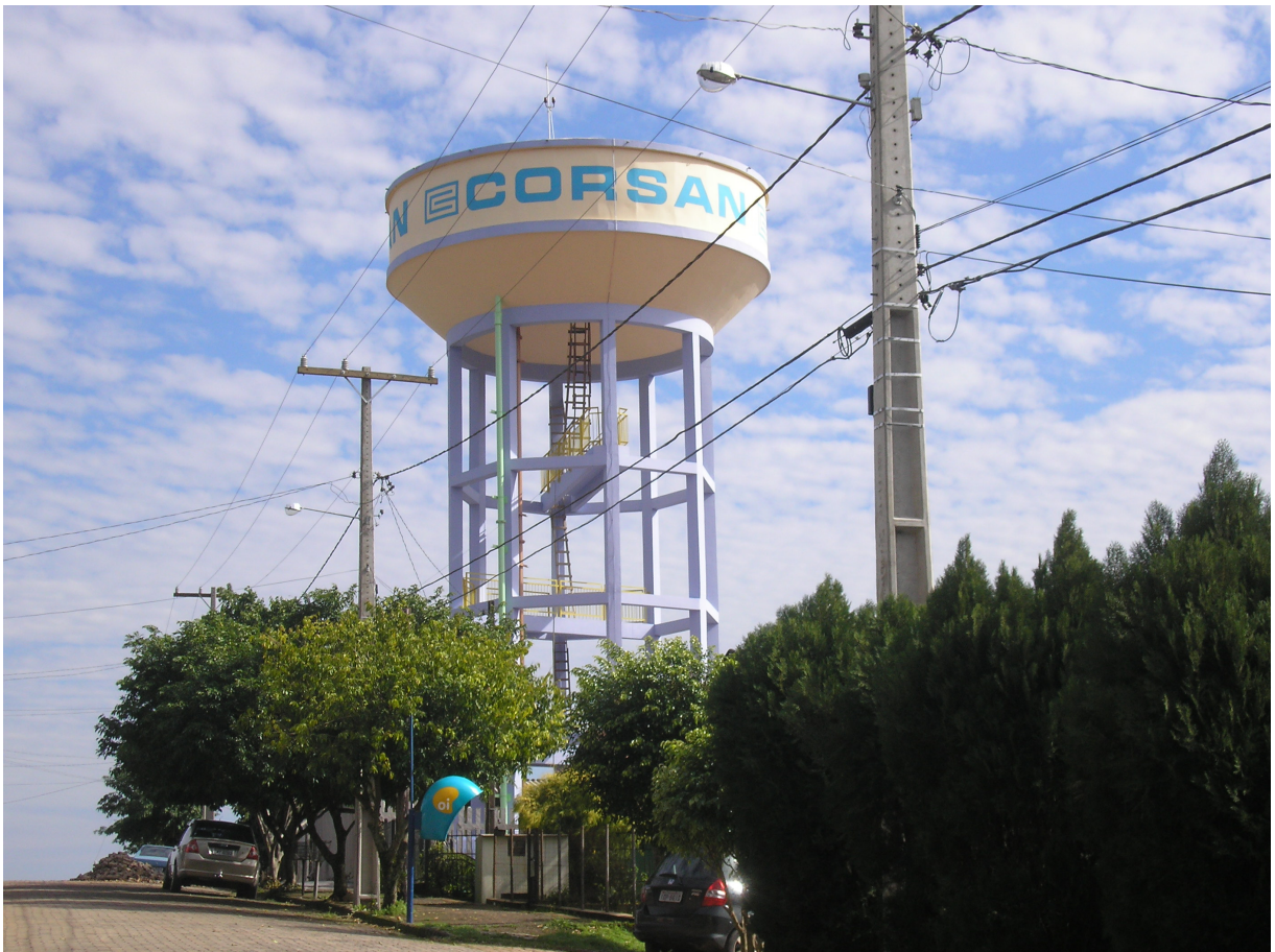
Figura 3.1 – Reservatório de concreto do tipo INTZE. Fonte: Autor (2011).
