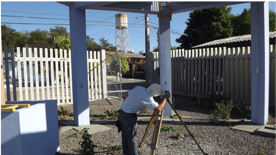
Figura 3.7 – Monitoramento do recalque da estrutura.
