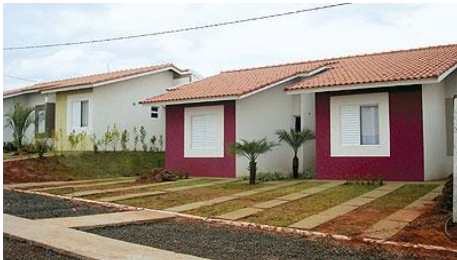
Figura 7 – Casas térreas construídas com sistemas de paredes de concreto
