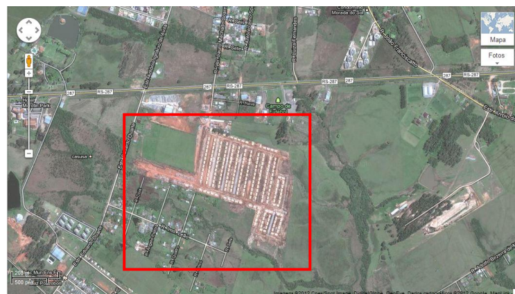
Figura 14 – Vista aérea do loteamento Zilda Arns
