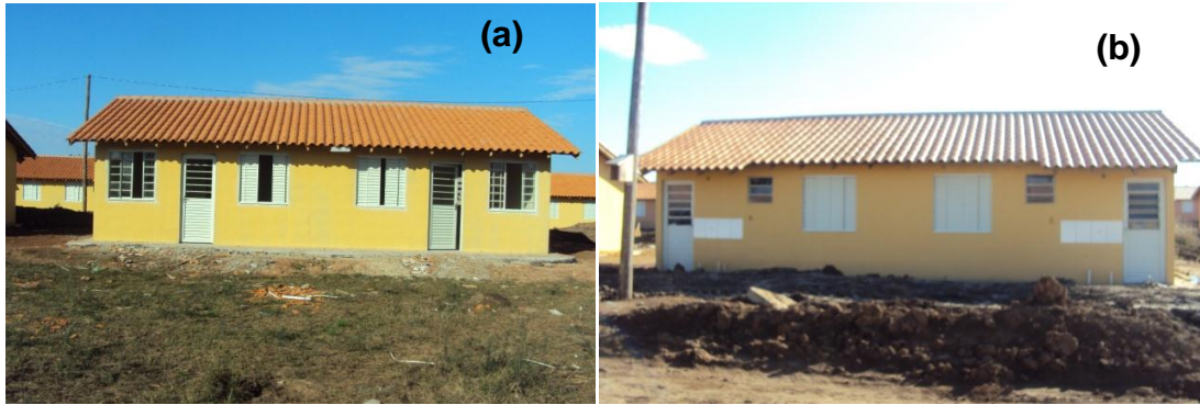
Figura 18 – Fachada frontal (a) e fachada de fundos (b)
