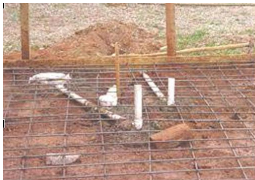
Figura 8 – Montagem do radier com as instalações elétricas e sanitárias embutidas
