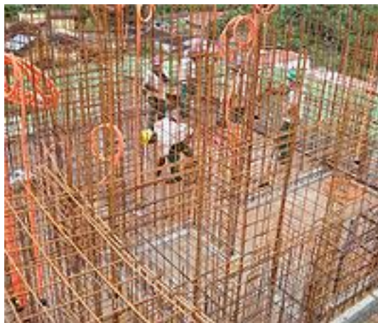
Figura 9 – Montagem das armaduras de paredes de concreto e colocação de eletrodutos
