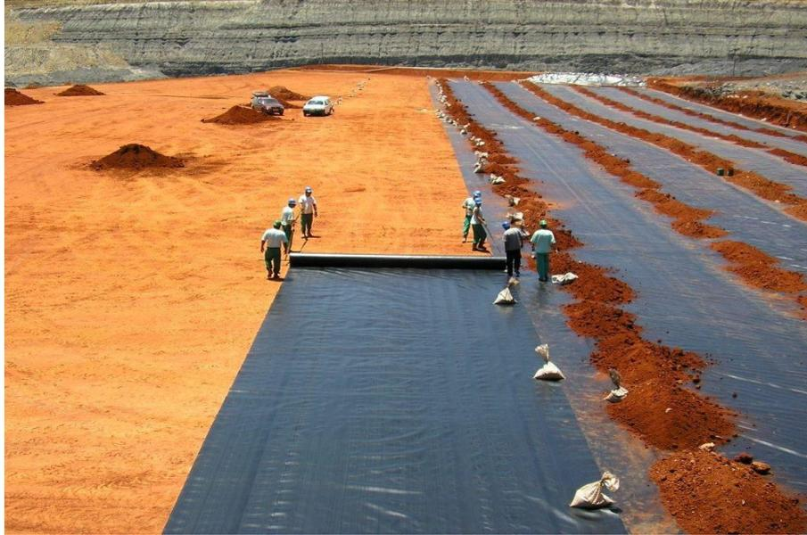
Figura 3.7 – Instalação da geomembrana PEAD sobre a camada de argila compactada.
