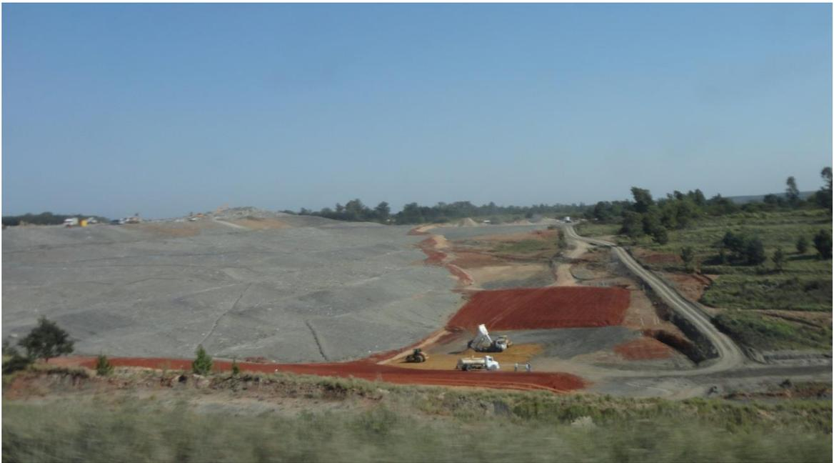
Figura 4.4 - Identificação das bermas de aproximadamente 5m no talude.
