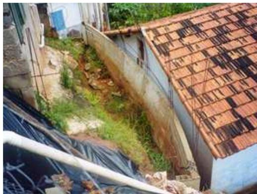
Figura 20 – Embarrigamento no pé do talude (MCIDADES, 2006).
