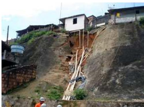
Figura 15 – Deslizamento de encosta provocado por águas servidas – Ipojuca / PE (ALHEIROS, 2003).
