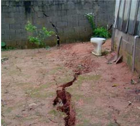
Figura 16 – Fendas no solo e fissuras na parede.
