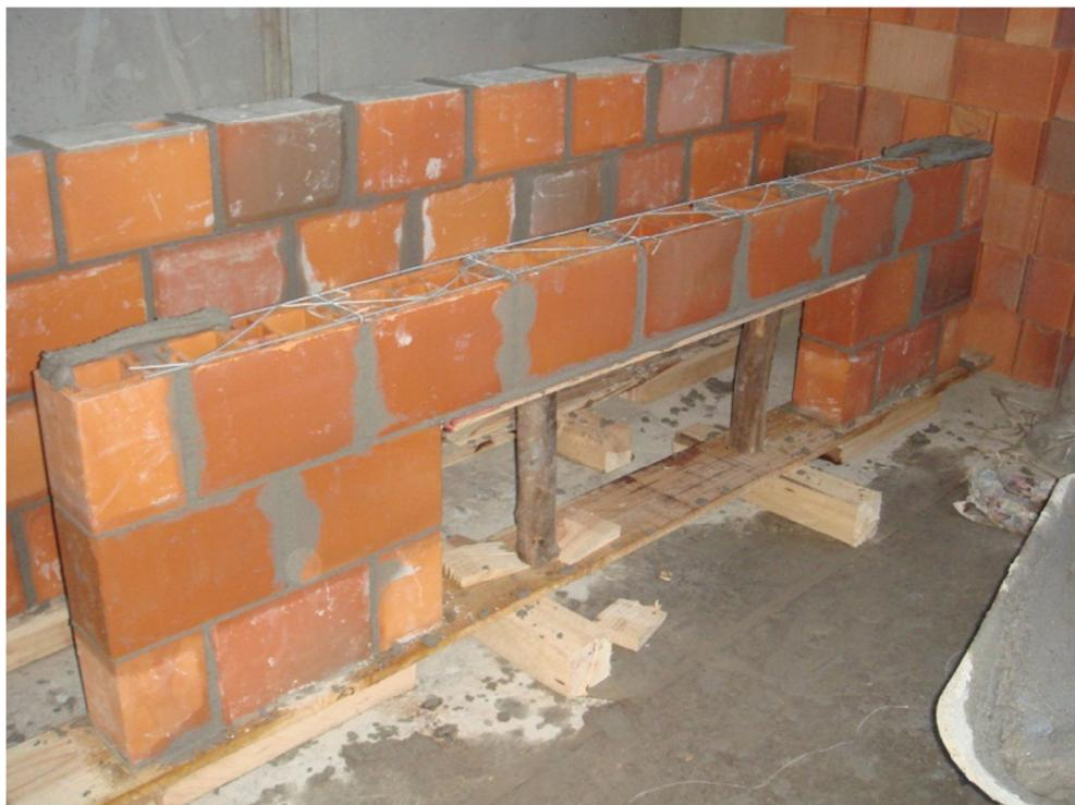
Figura 3.14 – Execução da segunda fiada sobre o vão do modelo VLT.
