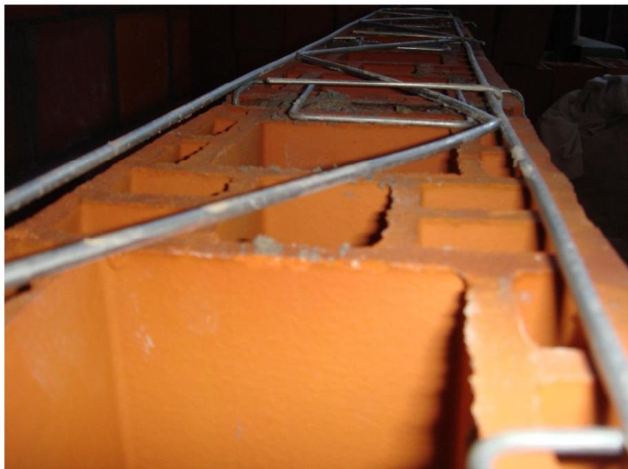
Figura 3.16 – Detalhe da ligação entre o estribo e a treliça.
