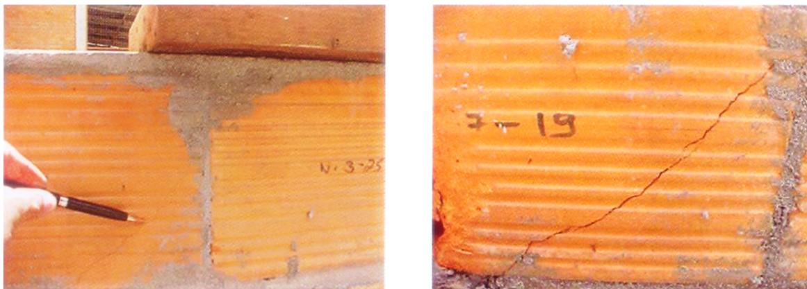
Figura 2.15 – Fissura observada na amostra 02.
