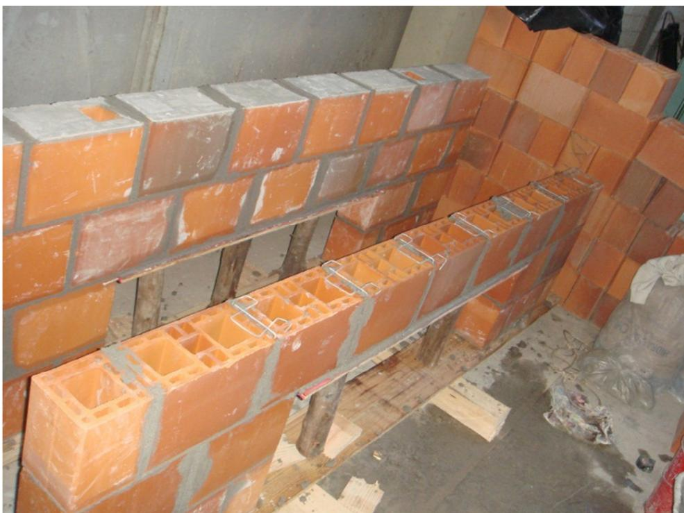
Figura 3.13 – Finalização da execução da primeira fiada sobre o vão do modelo VLT.
