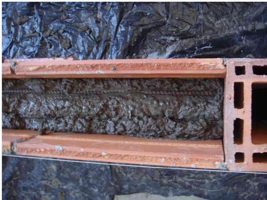
Figura 3.18 – Detalhe do preenchimento da verga do modelo VGL.
