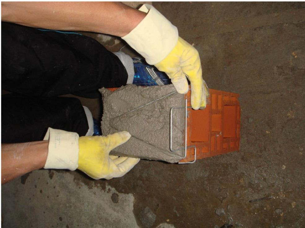
Figura 3.12 – Posicionamento do estribo.
