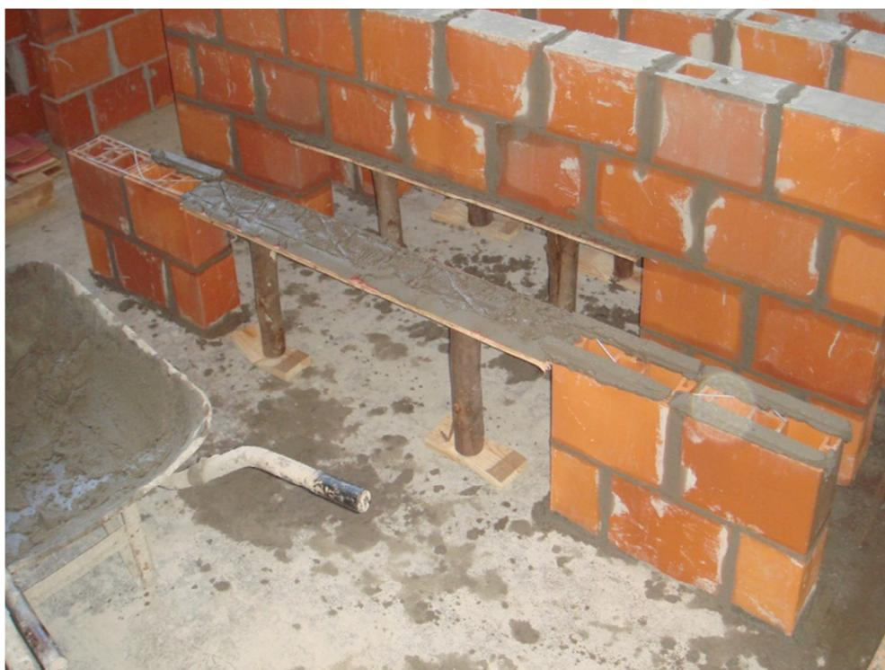
Figura 3.11 – Execução da primeira fiada sobre o vão do modelo VLT.
