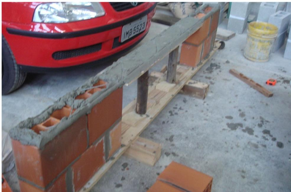
Figura 3.8 – Execução da primeira fiada sobre o vão do modelo VL.
