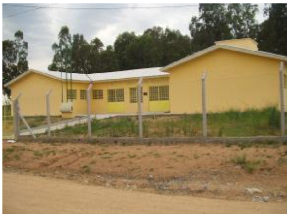
Figura 4.15 – Escola Municipal de Ensino Fundamental
