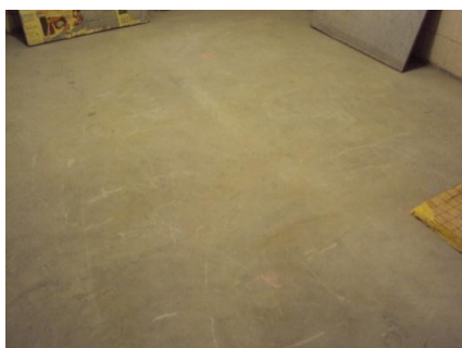
Figura 28 - Tipos de Piso: laje em “osso”.
