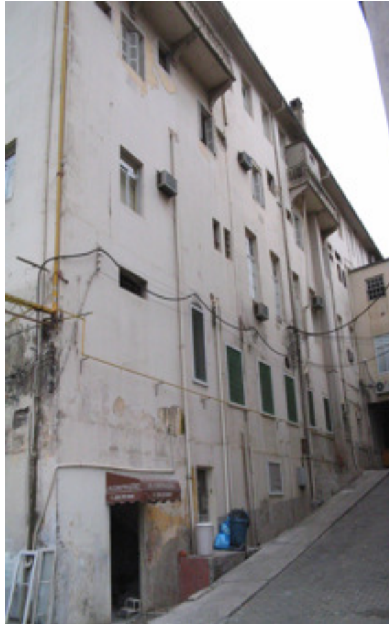
Figura 8 - Fachada Nordeste da Unidade Pediátrica
