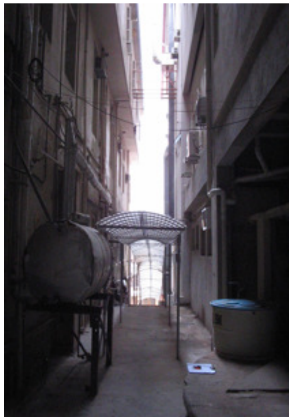
Figura 7 - Fachada Sudoeste Unidade Pediátrica
