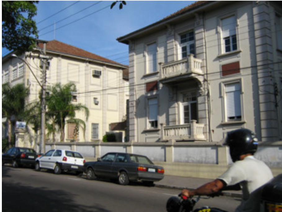
Figura 14 – Fachada noroeste da Maternidade.
