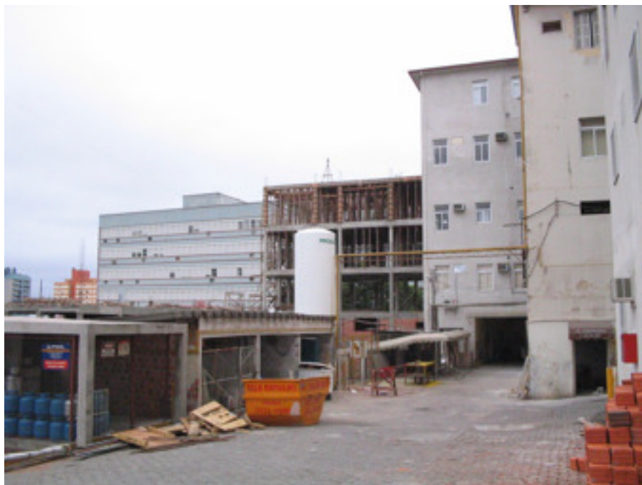
Figura 9 - Fachada Sudeste UP - obra e reservatório oxigênio
