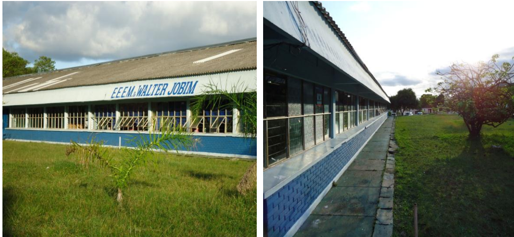
Figuras 4.1 e 4.2 – Fachada e vista lateral da Escola Walter Jobim Fonte: Autora.
