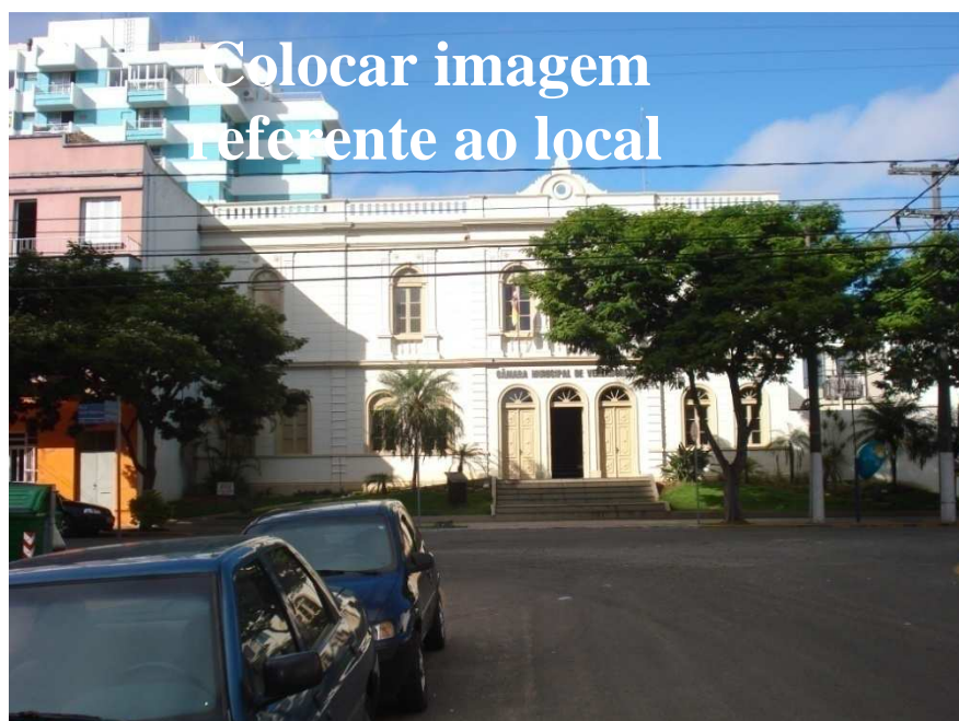
Figura 01: Fachada Norte da Câmara Municipal de Santa Maria Fonte: QUESADA, P.T (2010)
