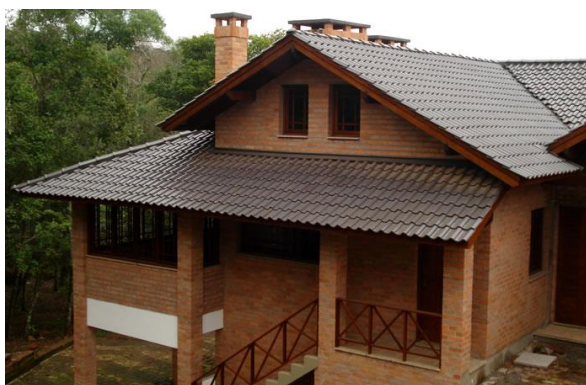
Figura 5 – Cobertura executada em telhas cerâmicas do tipo holandesas (Fonte: JOÃO VOGEL, 2013)
