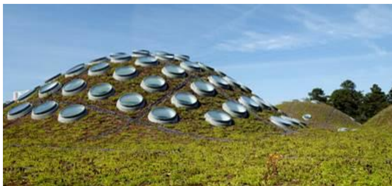
Figura 10 – Exemplo de cobertura verde extensiva na Califórnia, Estados Unidos (Fonte: DEZEEN, 2013, n.p.)
