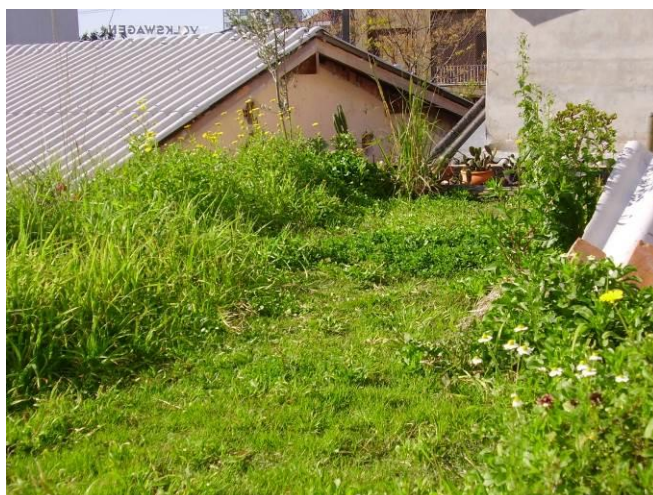
Figura 21 – Levantamento fotográfico da cobertura verde – Estudo de Caso 1 – Porto Alegre – RS
