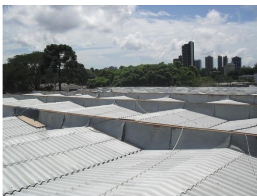
Figura 7 – Troca do telhado do hospital veterinário do campus agrárias da Universidade Federal do Paraná (Fonte: UFPR, 2013, n.p.)
