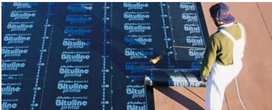
Figura 14 – Aplicação de manta asfáltica em uma laje de concreto (Fonte: ONDULINE, 2013, n.p.)
