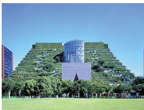
Figura 12 – Vista frontal do ACROS Fukuoka Prefectural International Hall no Japão. Edifício com sistema de cobertura verde intensiva (Fonte: GREENROOFS, 2013, n.p.)
