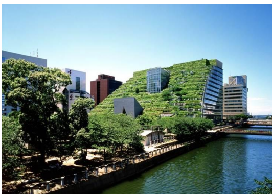
Figura 11 – No Japão o ACROS Fukuoka Prefectural International Hall é um edifício comercial com sistema de cobertura verde intensiva (Fonte: GREENROOFS, 2013, n.p.)
