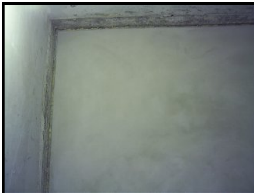
Parede com revestimento na sala de emissão
