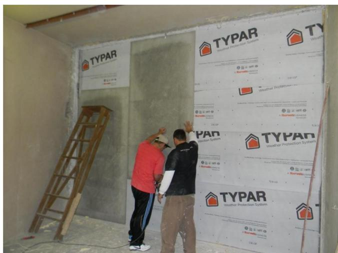
Figura 39 – Instalação da placa cimentícia sobre a membrana impermeável.
