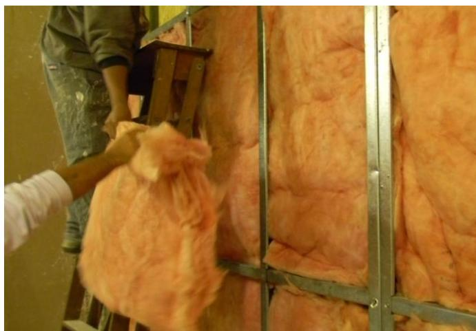
Figura 31 – Instalação da lã de vidro entre os perfis de *light steel frame*.
