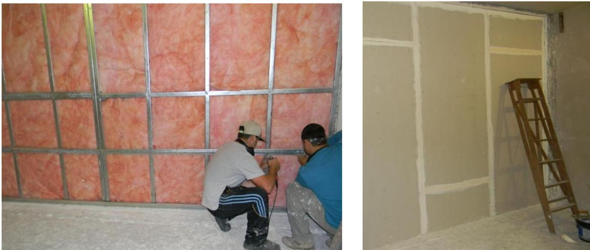
Figura 43 - Fixação das barras resilientes aos perfis e lado interno da parede de *light steel frame* revestida com placas de gesso.
