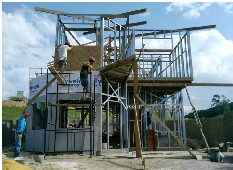
Figura 24 - Residência unifamiliar em *light steel frame*, Palhoça/SC, 2009.
