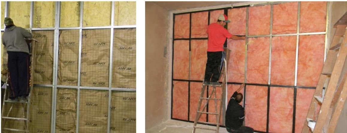
Figura 42 – Instalação da lã de vidro 50 mm e fita adesiva de espuma de PVC sendo colada em uma das faces dos perfis.
