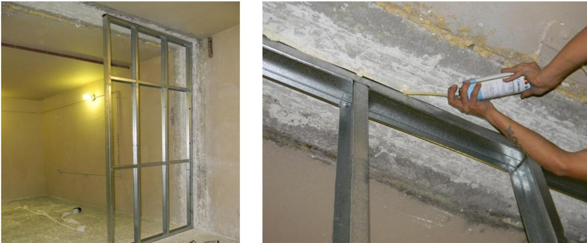
Figura 40 – Painel estrutural de aço fixado no vão da câmara e recebendo vedação com espuma expansiva de poliuretano.
