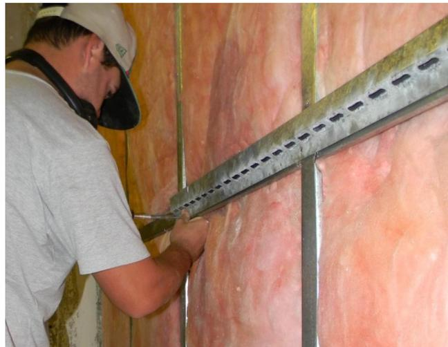
Figura 46 – Fixação da barra resiliente aos perfis da parede de *light steel frame*.
