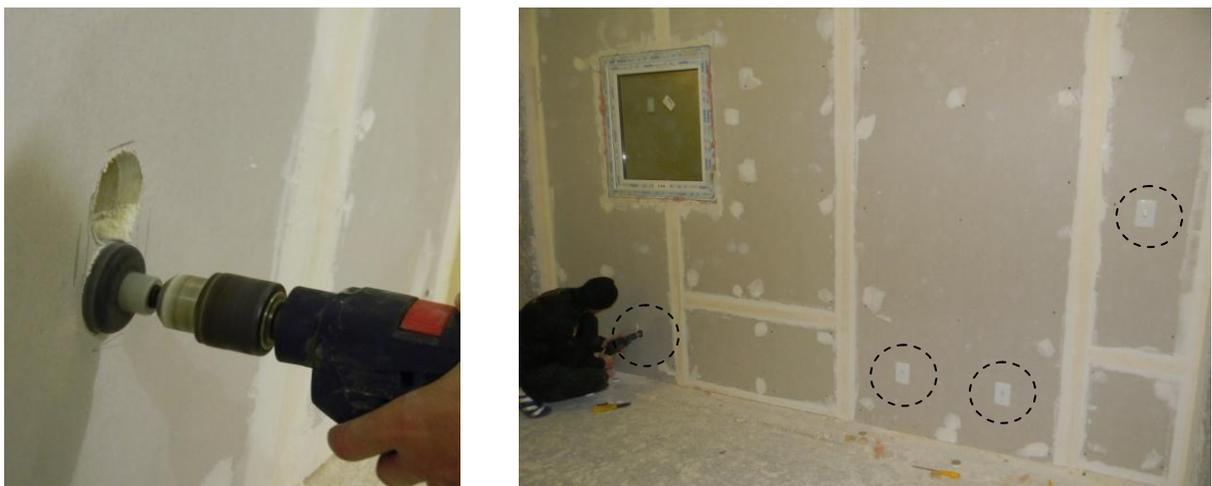
Figura 49 – Furos para instalação e posições das caixas de luz na parede de *light steel frame* - P23.
