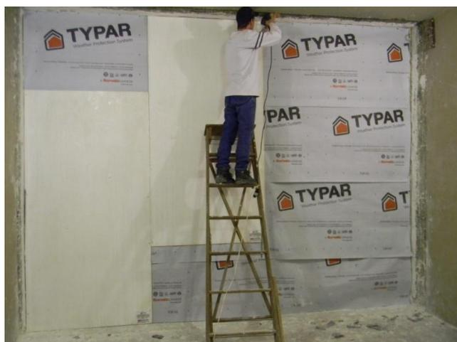
Figura 38 – Instalação das placas de óxido de magnésio na parede de *light steel frame*.
