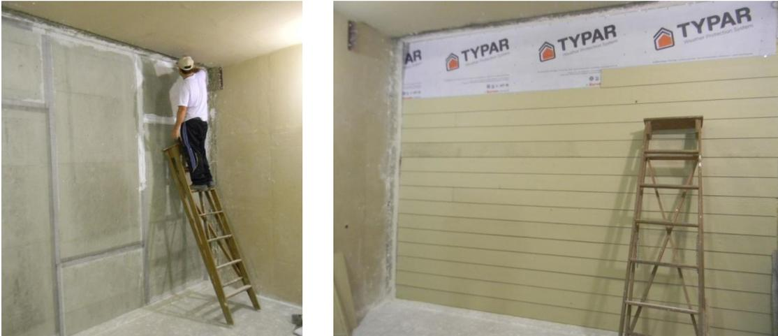
Figura 47 - Lado externo das paredes de *light steel frame* revestidas com placas cimentícias e régulas *Smartside*.
