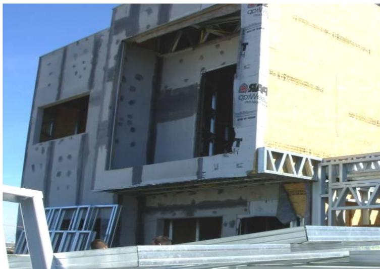
Figura 25 - Residência multifamiliar em *light steel frame*, Eldorado do Sul/RS, 2012.
