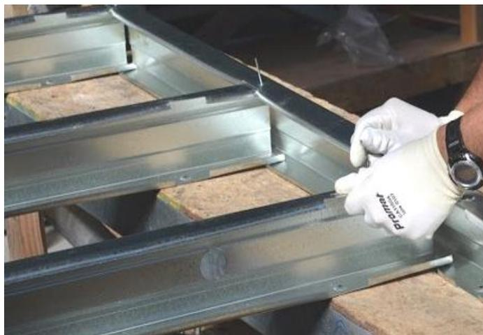
Figura 30 – Encaixe dos montantes na guia em painel estrutural de *light steel frame*.
