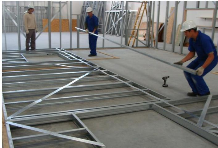
Figura 26 – Montagem dos painéis em light steel frame, na fábrica.
