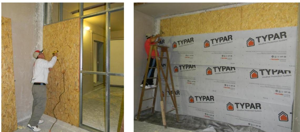
Figura 41 – Revestimento do painel estrutural utilizando painel OSB e instalação da membrana hidrófuga sobre os painéis OSB.
