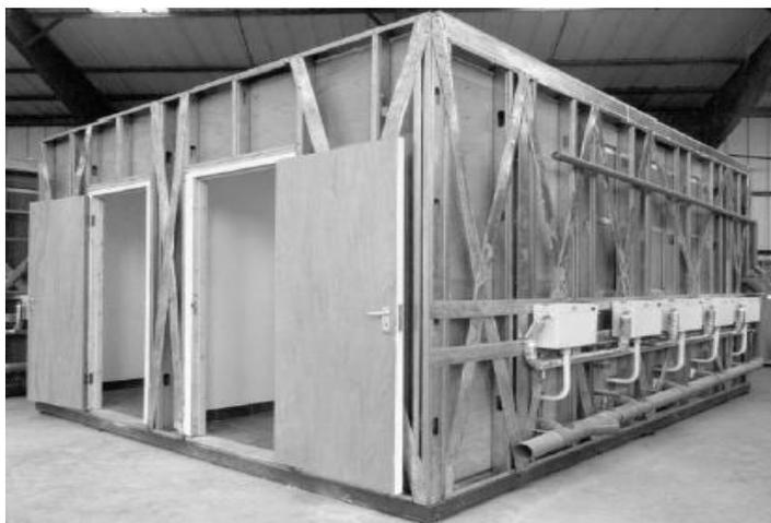
Figura 27 – Montagem do módulo de banheiro em *light steel frame*, na fábrica.
