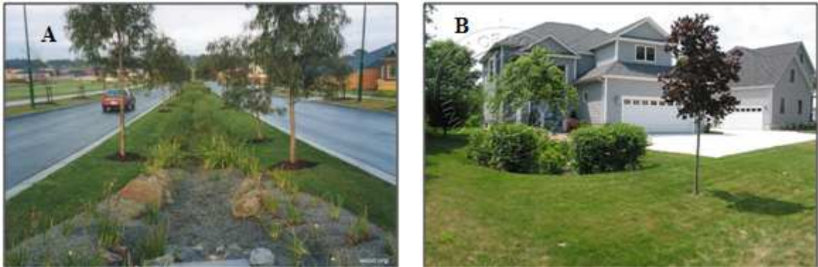
Figura 1. Foto A) Uso de biorretenção em via pública para o controle do escoamento pluvial na fonte. Fonte: wsud.org (2014). Foto B). Uso de biorretenção em lote para o controle do escoamento pluvial na fonte. Fonte: jordancove.uconn.edu (2014).
