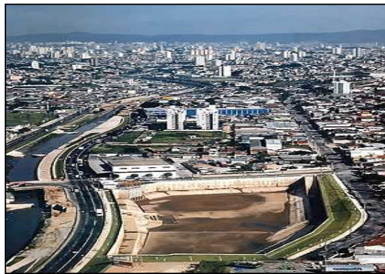
Figura 3. Exemplo do uso de bacia de retenção (Reservatório Aricanduva 5), instalada na região de São Mateus (SP). Fonte: hidrostudio.com.br (2014)
