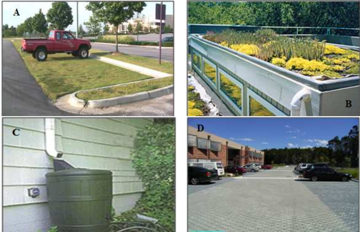
Figura 4. Exemplos de utilizações de LID. Foto A. Biorretenção, instalada em estacionamento em Massachusetts (EUA). Fonte: mass.gov (2014). Foto B. Telhado verde, instalado em Washington (EUA). Fonte: epa.gov (2014). Foto C. Barril de chuva instalado. Fonte: epa.gov (2014). Foto D. Pavimento permeável, instalado na Austrália. Fonte: wsud.org (2014).
