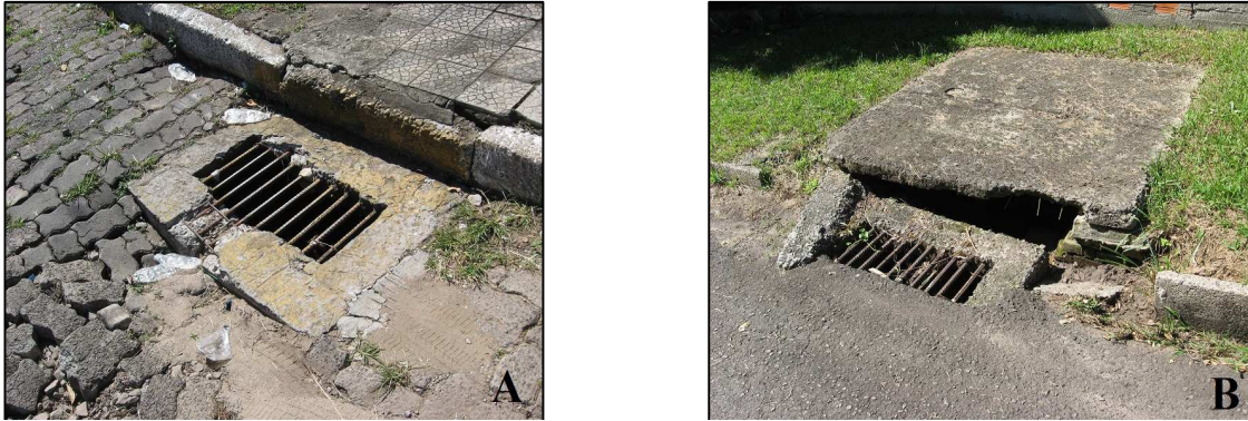
Figura 10 - Elementos de microdrenagem da área urbana de Santa Maria. Fonte: Autor (2014).
