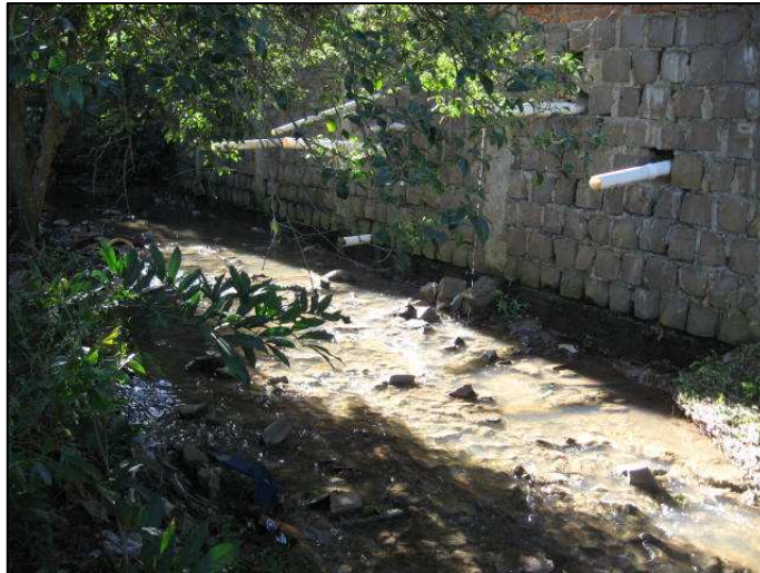
Figura 14 - Ligações errôneas das saídas do esgoto cloacal à rede de drenagem pluvial em trecho da Sanga Lagão do Ouro na zona leste da área urbana de Santa Maria. Fonte: Autor (2014).
