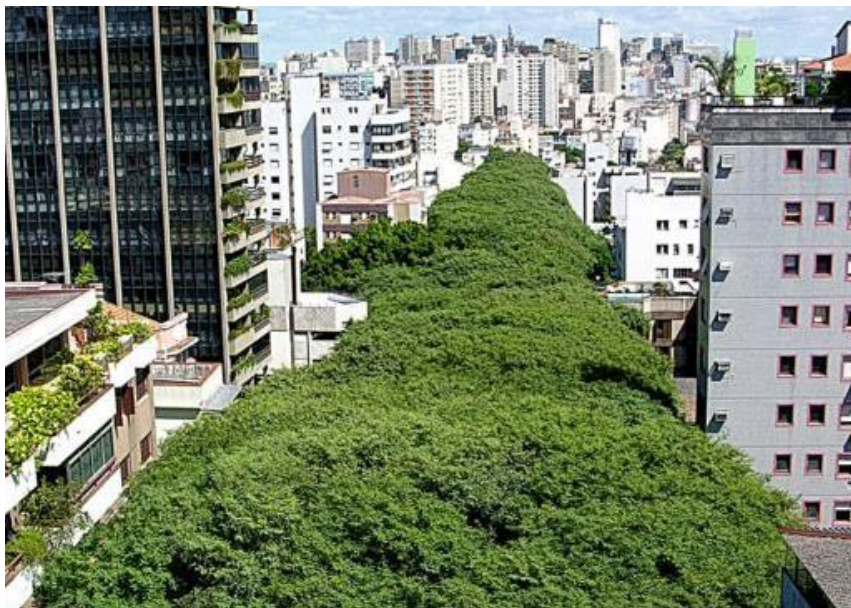
Figura 2.2 – Vista do corredor verde da rua Gonçalo de Carvalho, em Porto Alegre Fonte: Blog Geração urbana
