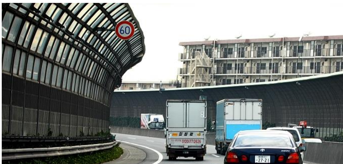
Figura 2.6 – Barreira acústica convencional no Japão Fonte: Site Japan Dish
