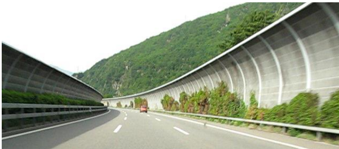
Figura 2.7 – Barreira acústica convencional em rodovia
