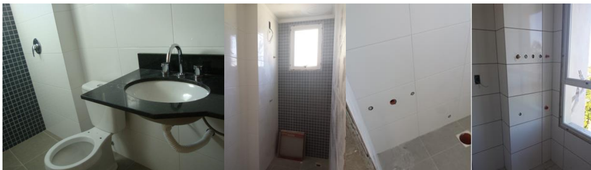
Figura 4.4 - Acabamentos dos banheiros do Residencial do Parque, espera para água quente no banheiro e saída para aquecimento a gás na área de serviço
