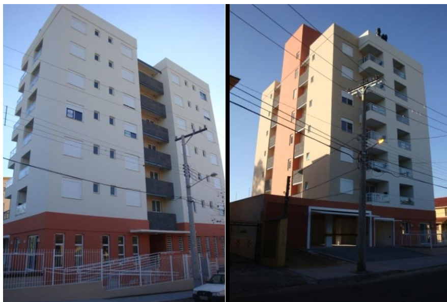
Figura 4.2 – Fachadas sul-leste e oeste-sul do Residencial do Parque
