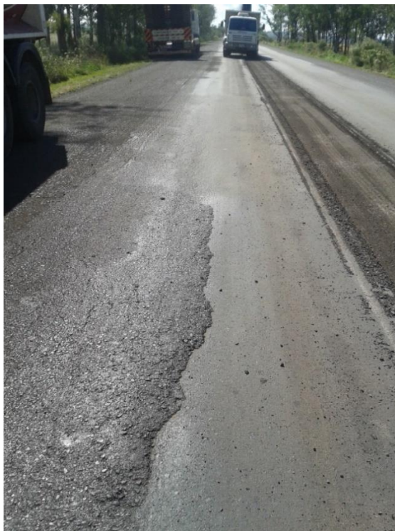
Figura 26 – Vista do trecho em que foi realizada a fresagem da pista
