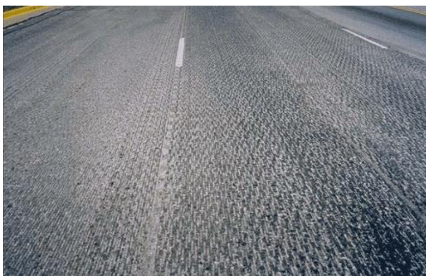
Figura 1 – Superfície típica resultante de fresagem a frio
