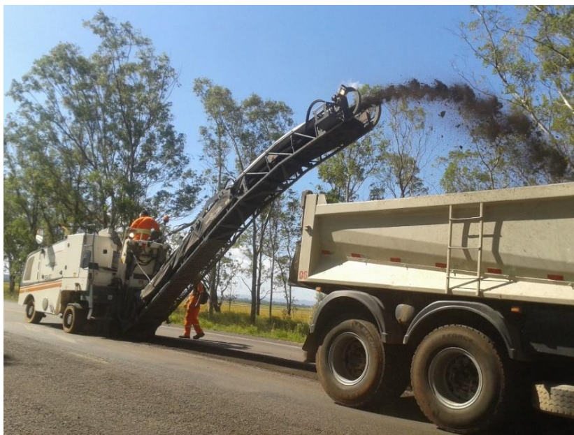
Figura 27 – Coleta da amostra diretamente da fresadora
