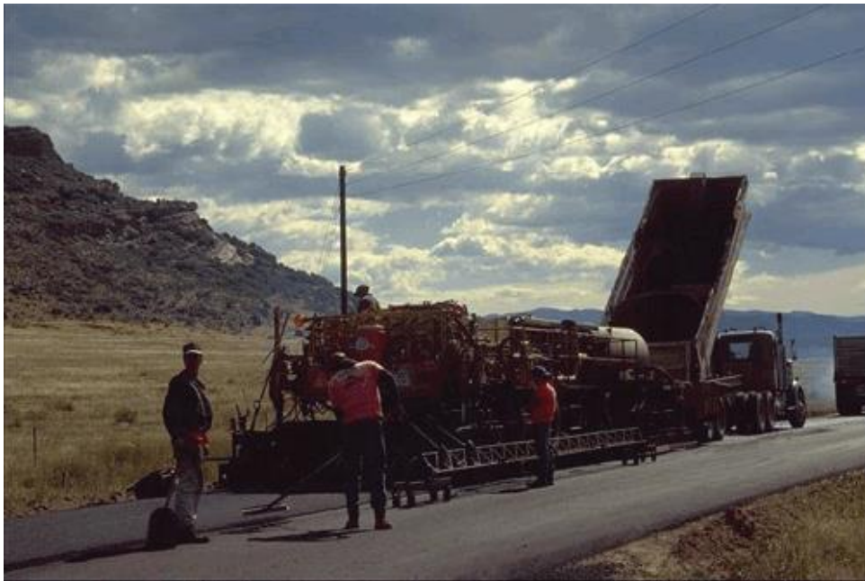
Figura 4 – Processo de Repavimentação
