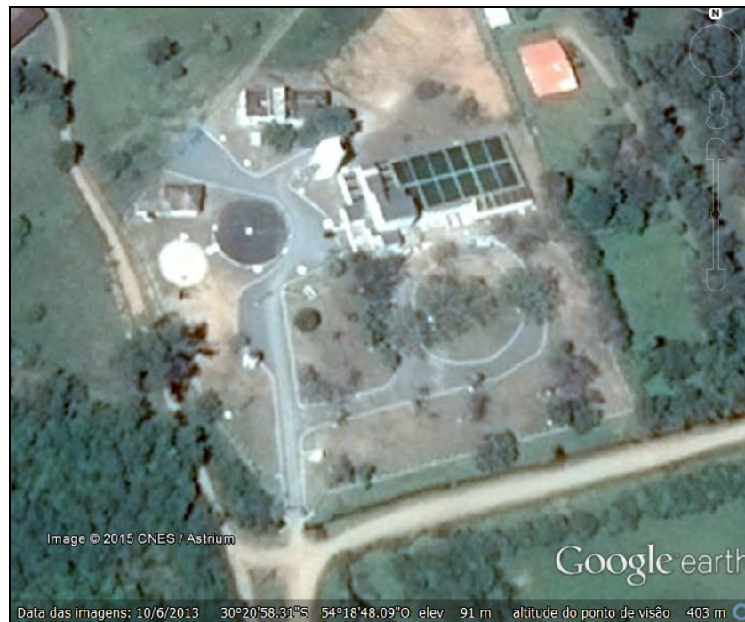
Figura 10 - Localização da área da Estação de Tratamento de Água de São Gabriel.
