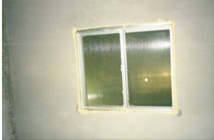
Figura 40 – Instalação de uma janela com tecnologia regional
