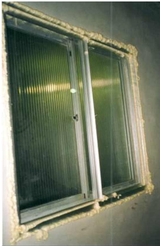
Figura 41 – Instalação de duas janelas com tecnologia regional
