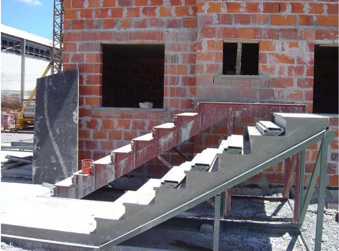
FIGURA 5.53 – Exemplo de escada pré-moldada de concreto (SANTOS, 2004).
