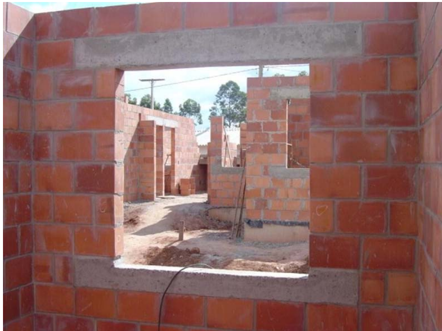
FIGURA 5.31 – Verga e contra-verga com transpasse adequado (SANTOS, 2004).
