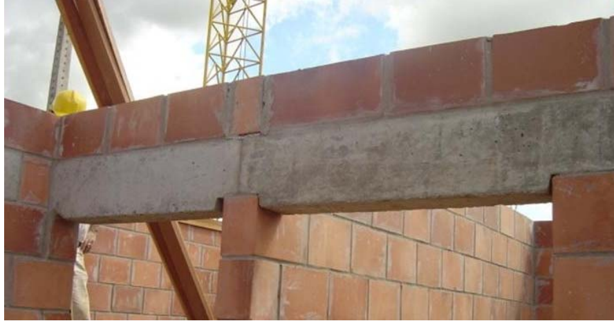
FIGURA 5.30 – Verga pré-fabricada de concreto (SANTOS, 2004).
