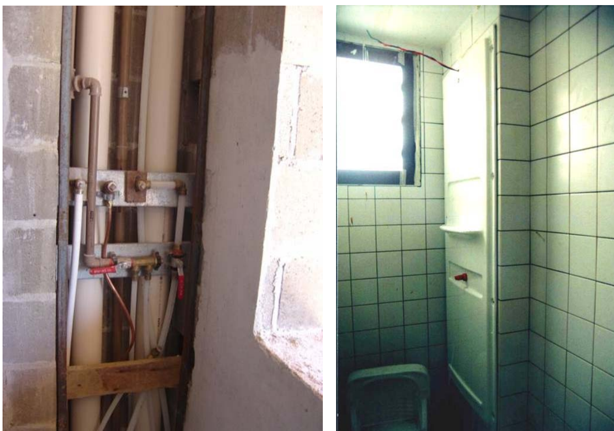
FIGURA 5.41 – Exemplos de shafts hidráulicos visitáveis (SANTOS, 2004).
