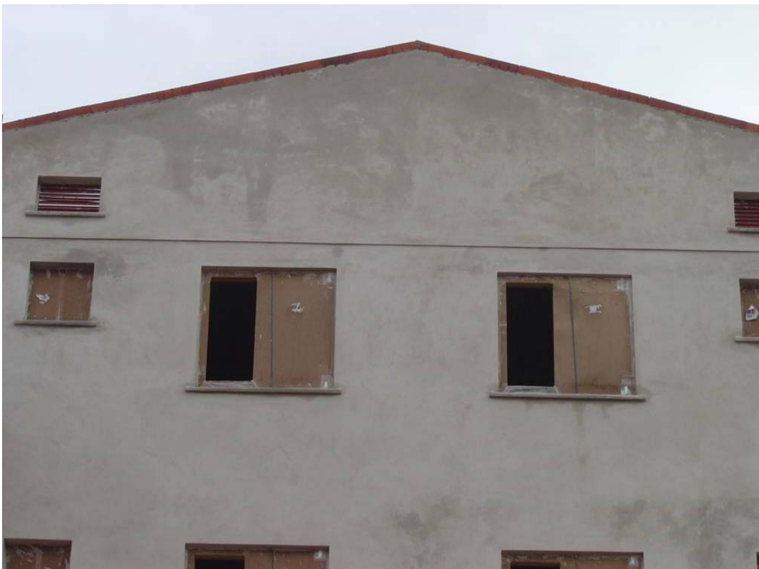
FIGURA 5.54 – Exemplo de ventilação de cobertura (SANTOS, 2004).
