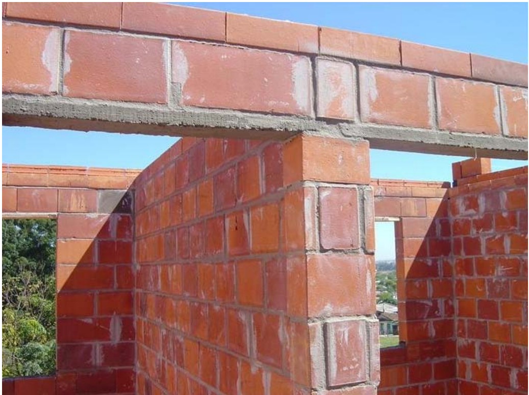
FIGURA 5.29 – Verga de concreto moldada in loco (SANTOS, 2004).
