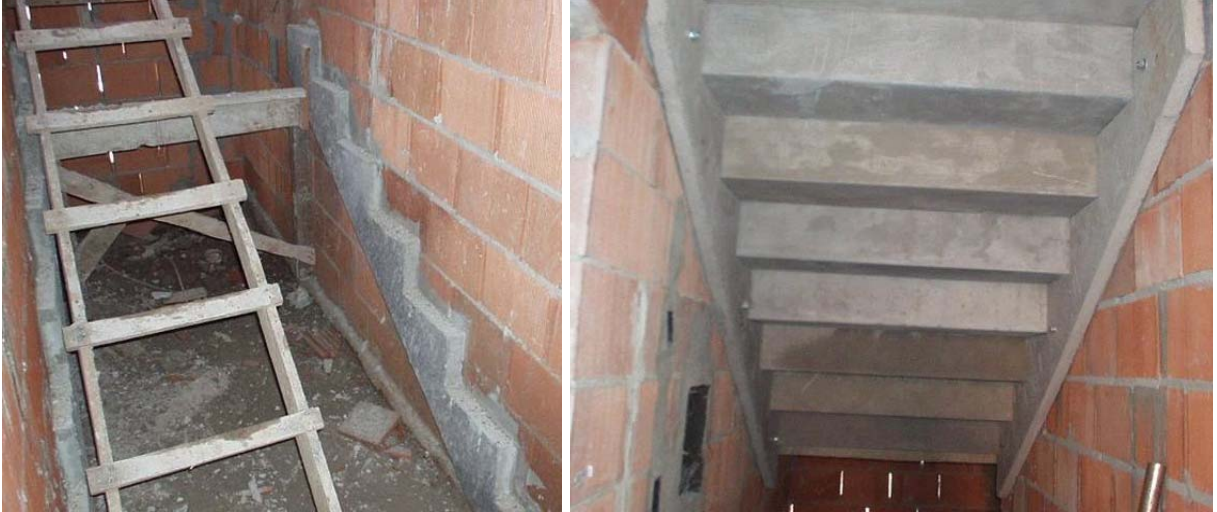
FIGURA 5.51 – Etapas da execução da escada do tipo jacaré (SANTOS, 2004).
