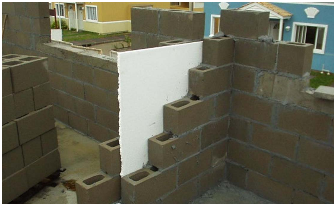
FIGURA 5.35 – Junta de dilatação em execução (SANTOS, 2004).
