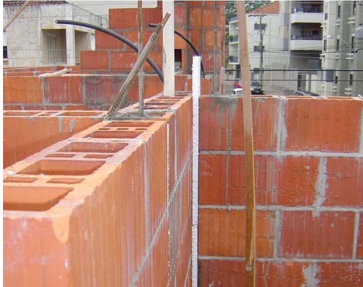
FIGURA 5.32 – Junta de controle em execução (SANTOS, 2004).
