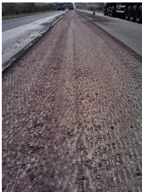
Figura 1 - Trecho fresado na BR – 392
