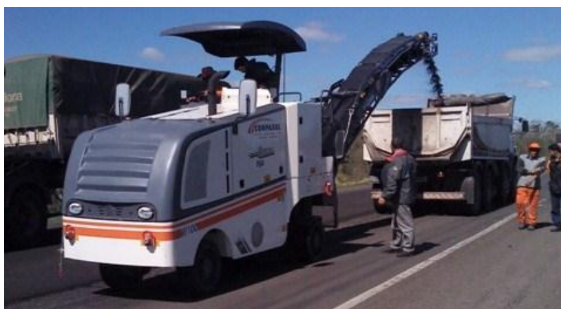
Figura 16- Fresagem do material in situ .
