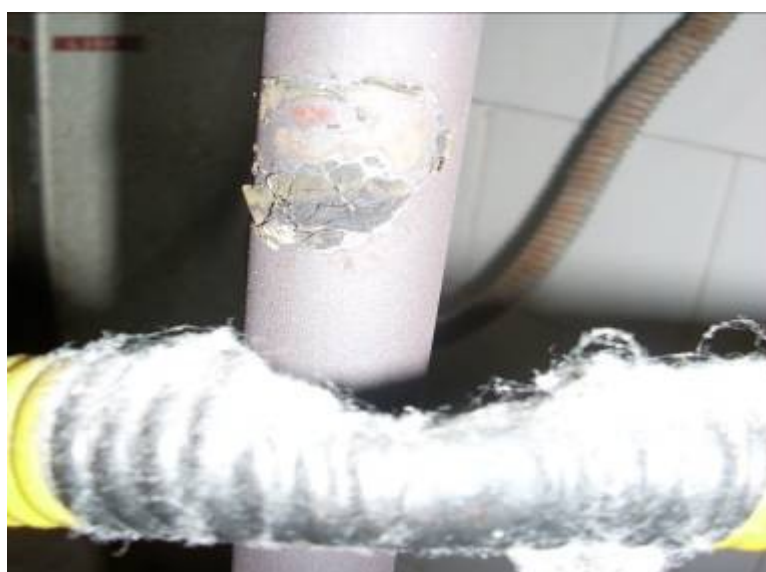
Figura 12 – Proteção da fiação danificada
