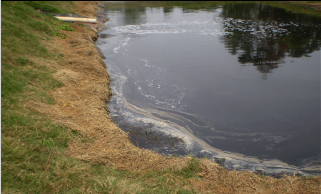
Figura 4.23 - Primeira lagoa facultativa impermeabilizada no abatedouro Tropeiro
