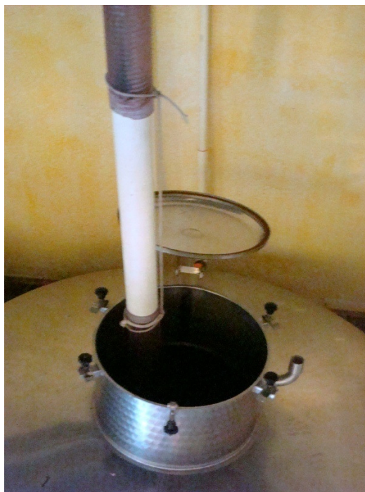
Figura 28 - Mangueira de transferência da uva moída Fonte: Autora
