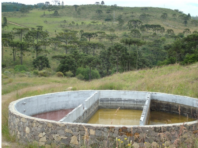
Figura 40 - Tanque receptor do efluente tratado.
