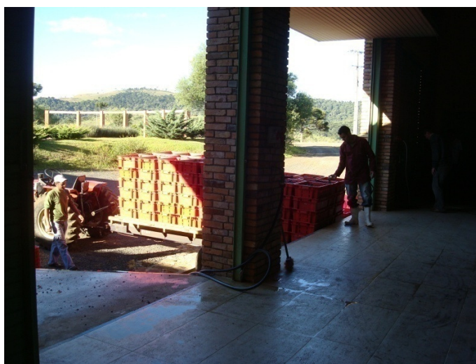
Figura 21 - Desnível entre a rampa e veículo na área de recebimento. Fonte: Autora
