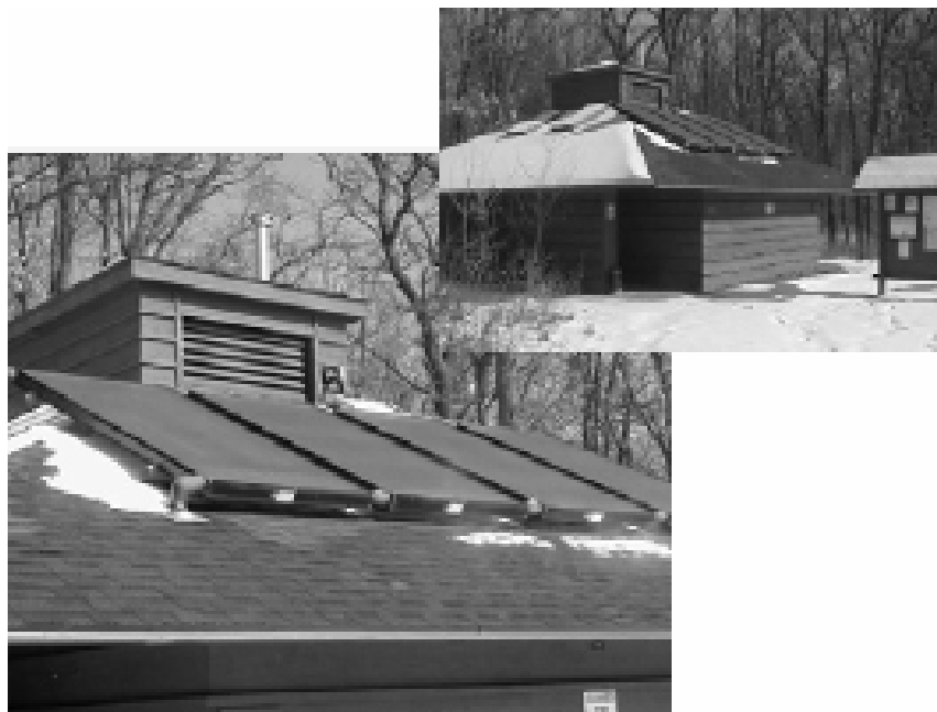
Figura 10 – Painéis solares de aquecimento do Wild River State Park. Fonte: Resumo do projeto Wild River State Park (TMP, 2003).
