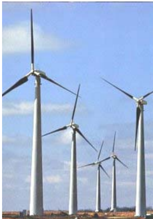
Figura 3 – Foto de uma turbina de eixo horizontal. Fonte: Union of Concerned Scientists (UCS, 2004).
