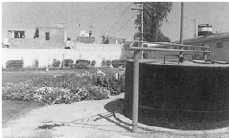
Figura 17 – Foto de um biodigestor de domo flutuante em um complexo do projeto SULABH. Fonte: Sulabh International Social Service Organization (SULABH, 2005).
